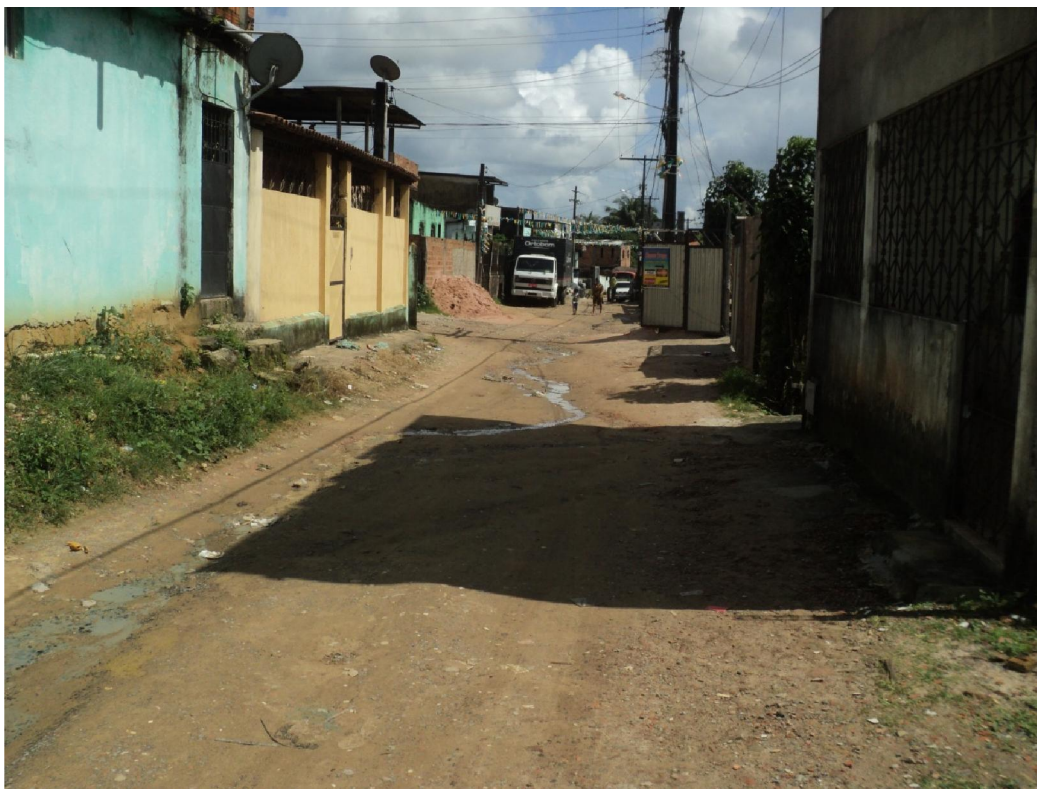
Foto 3 – Esgoto a céu aberto
