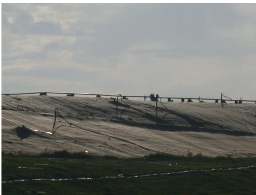
Figura 18. Vista parcial da tubulação que captura o biogás do Aterro Metropolitano Centro – Salvador/BA.
