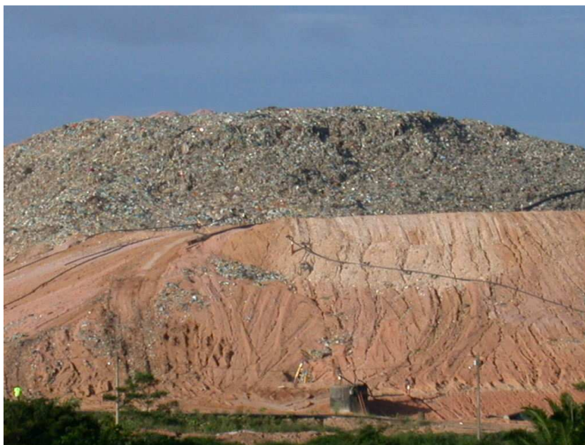
Figura 17. Vista parcial de uma das frentes de trabalho do AMC – Salvador/BA – lixo disposto sem a devida cobertura com material argiloso por muito tempo
