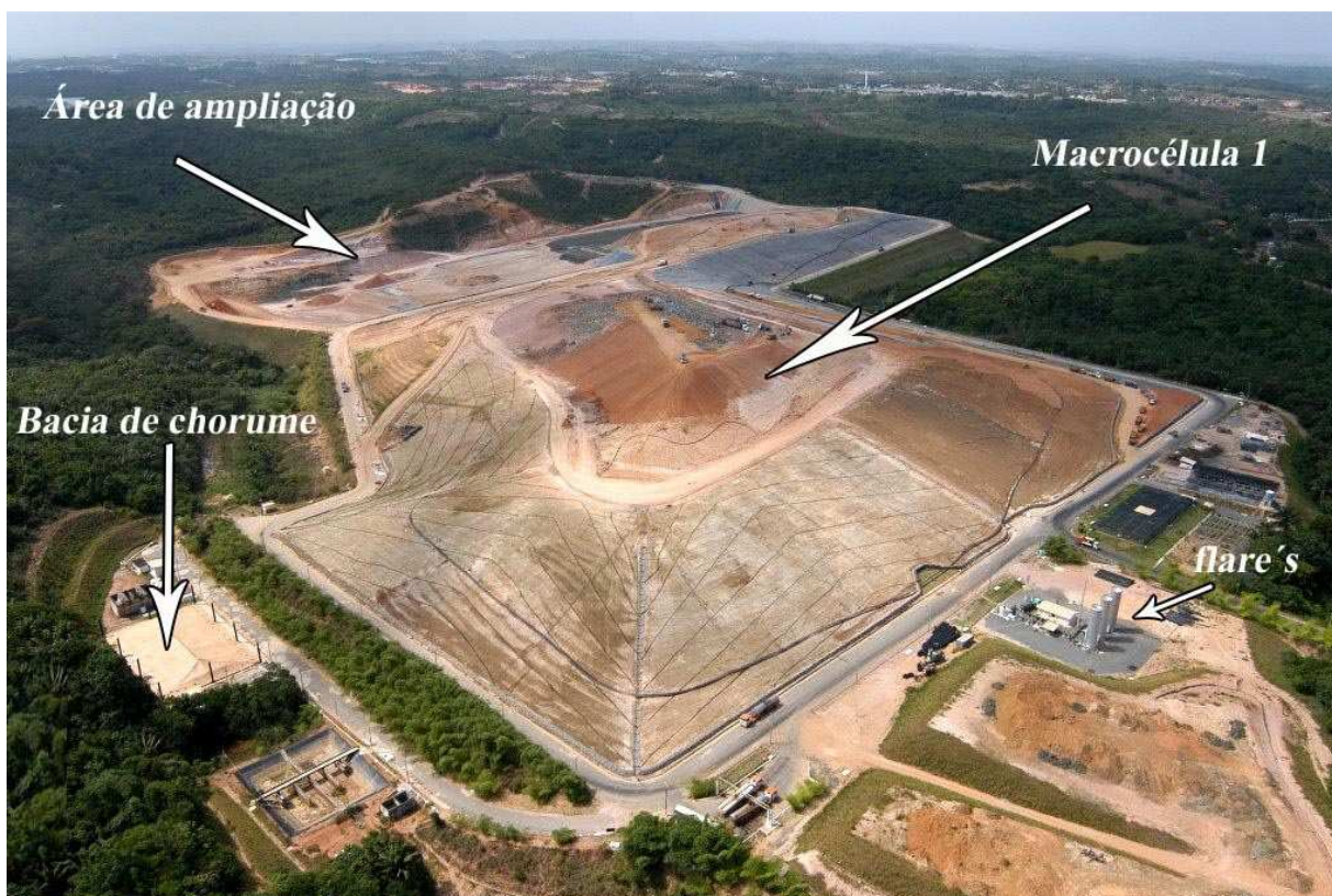
Figura 15. Vista aérea do Aterro Metropolitano Centro – Salvador/BA.
