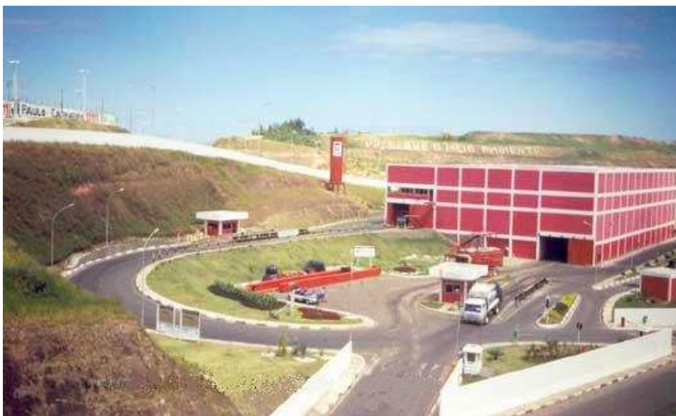
Figura 19. Vista da Estação de Transbordo em Canabrava – Salvador/BA.
