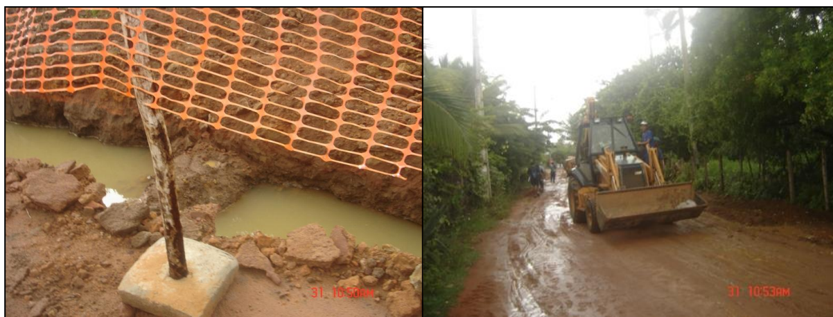
Figura 16: Obras de urbanização que estão sendo realizadas pela CONDER com recursos do PRODETUR II na entrada de Imbassaí
