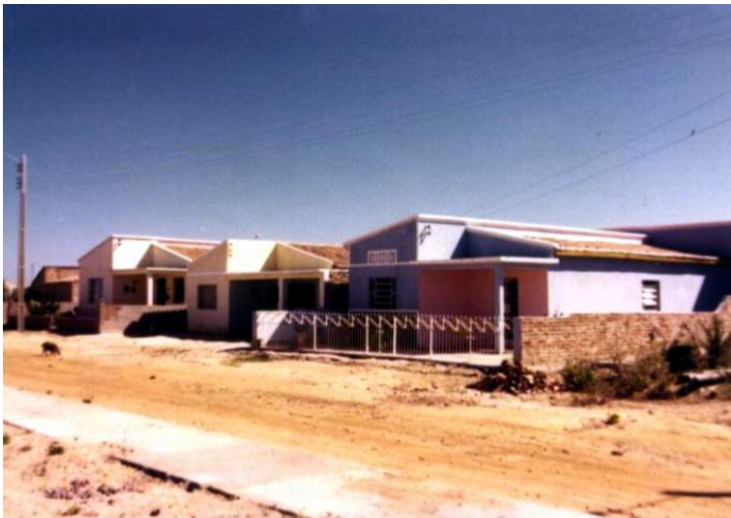
Figura 54: Rua de casas “tipo III”. Fonte:CHESF
