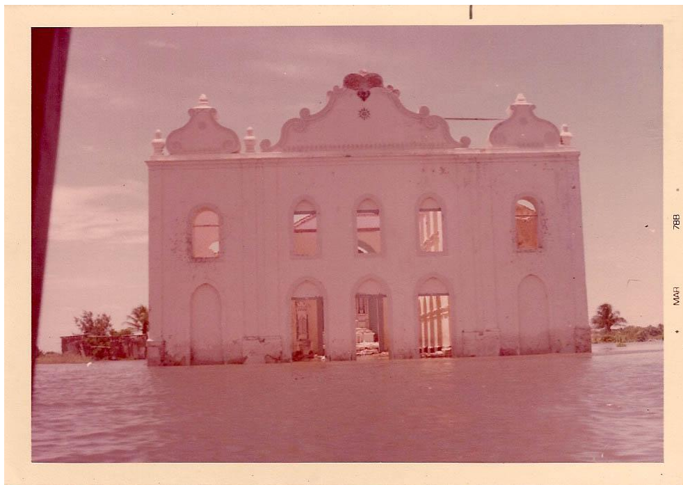
Figura 50: Igreja Matriz, sendo alagada. Março de 1978.
