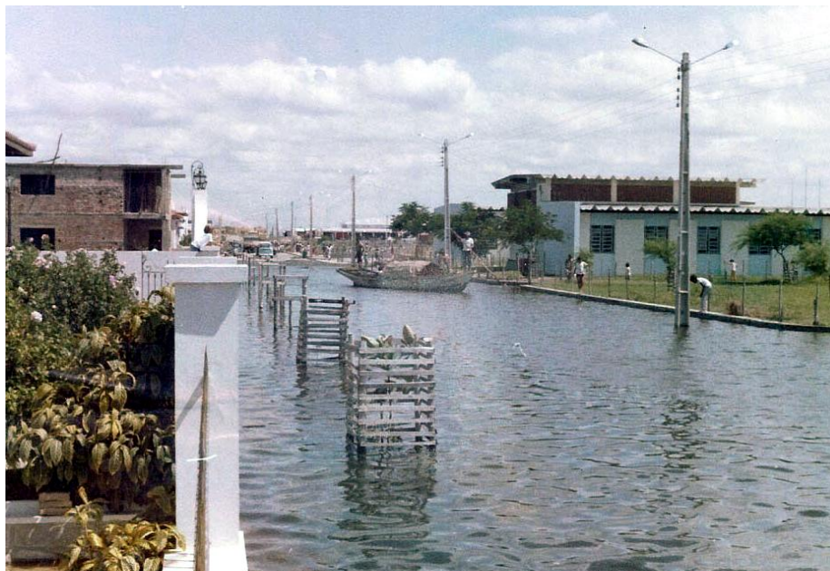
Figura 58: Inundação na Nova Remanso. 1980. Fonte: Cândido Coêlho
