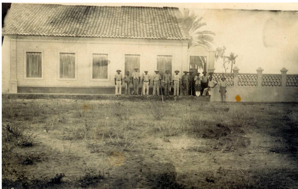
Figura 71: Casa de Alcides Modesto, com trabalhadores na frente. Data e autoria desconhecidas. Fonte: Família Modesto.
