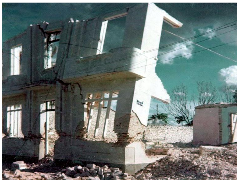
Figura 47: Momento da demolição da Prefeitura de Remanso
