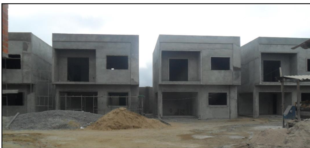
Figuras 16 – Condomínio Morada das Flores (em construção) - 2013
