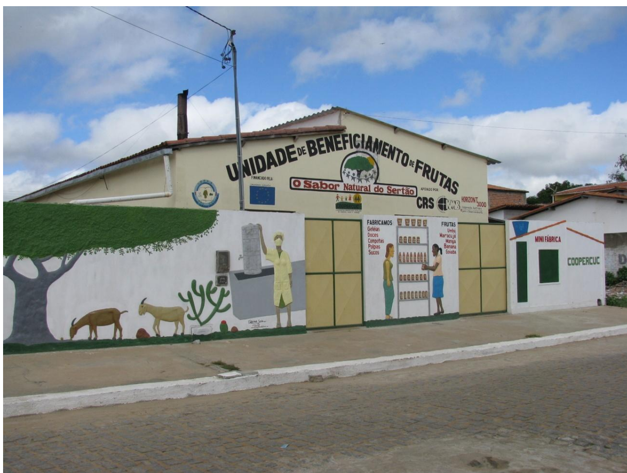
FIGURA 10: Fábrica central da COOPERCUC na cidade de Uauá Foto: Arquivo IRPAA
