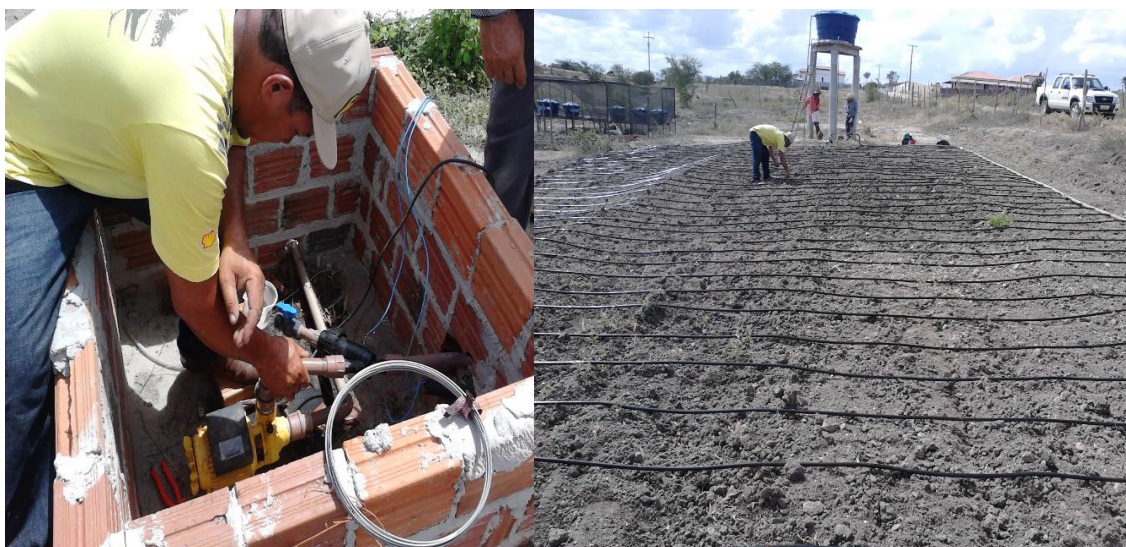
Figura 6. Montagem sistema de irrigação em área piloto.
