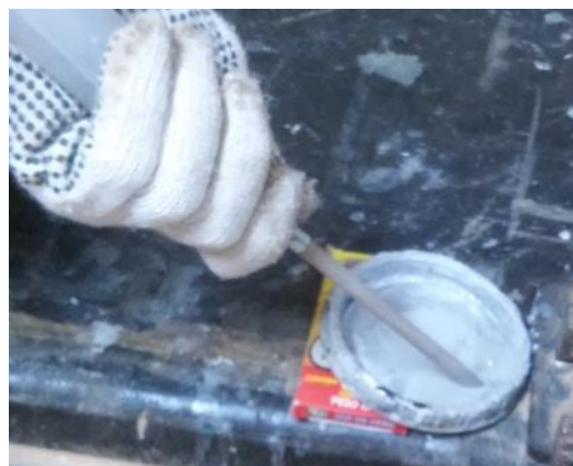
Figura 34. Sucção do epóxi (Fonte: O autor).
