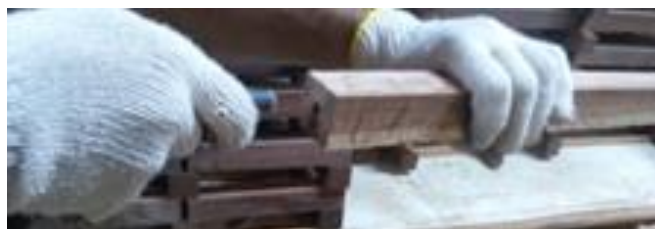
Figura 31. Limpeza do furo da madeira (Fonte: O autor).
