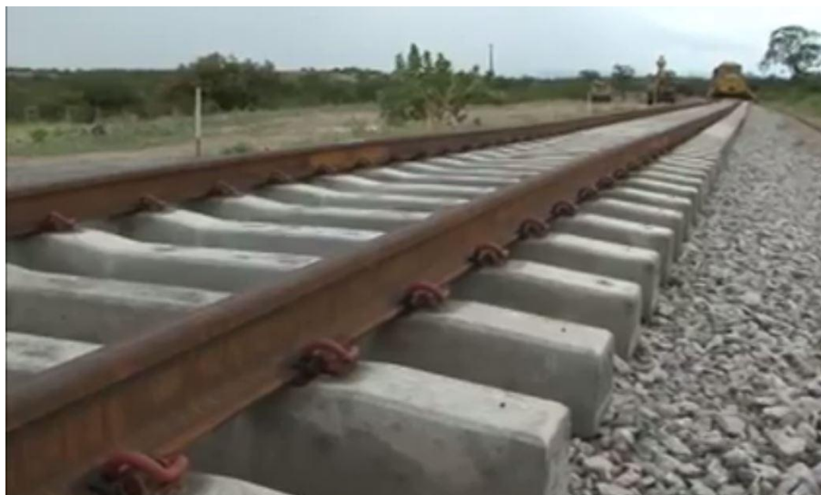
Figura 11 - Trecho em Construção da FIOLE
