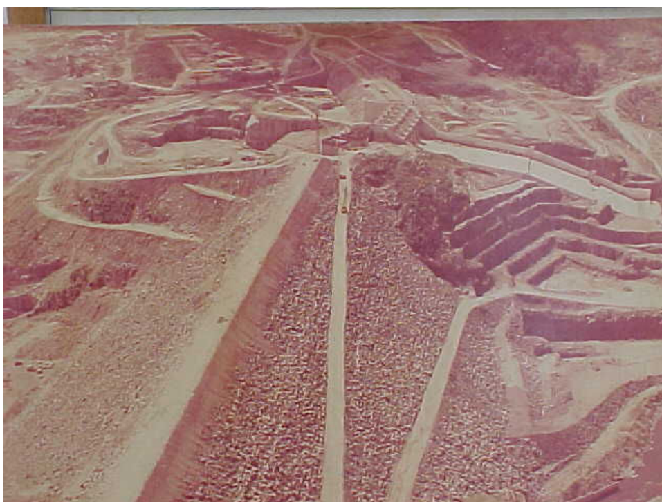
Foto 3 – Eixo e vertedouro - Obras da Barragem de Pedra do Cavalho.– BA. 1979. Elaboração PALMA, E.G.A. (2007)
