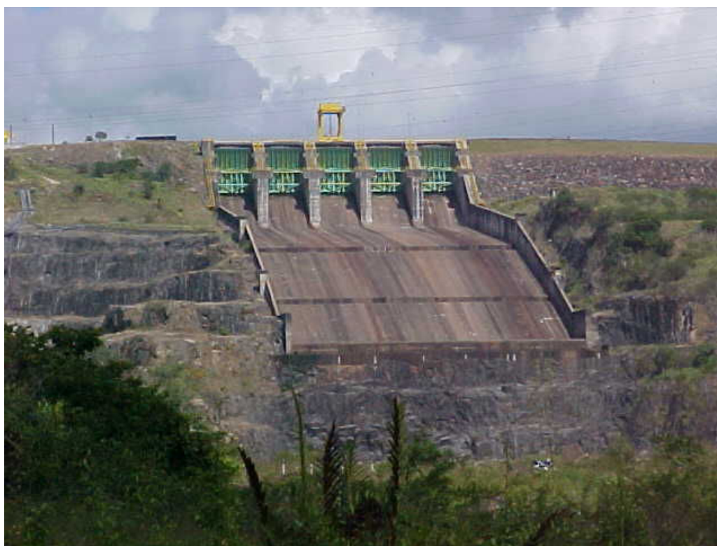
Foto 4 – Barragem de Pedra do Cavalo.(vertedouro em destaque) – BA. 2005. Elaboração PALMA, E.G.A. (2007)
