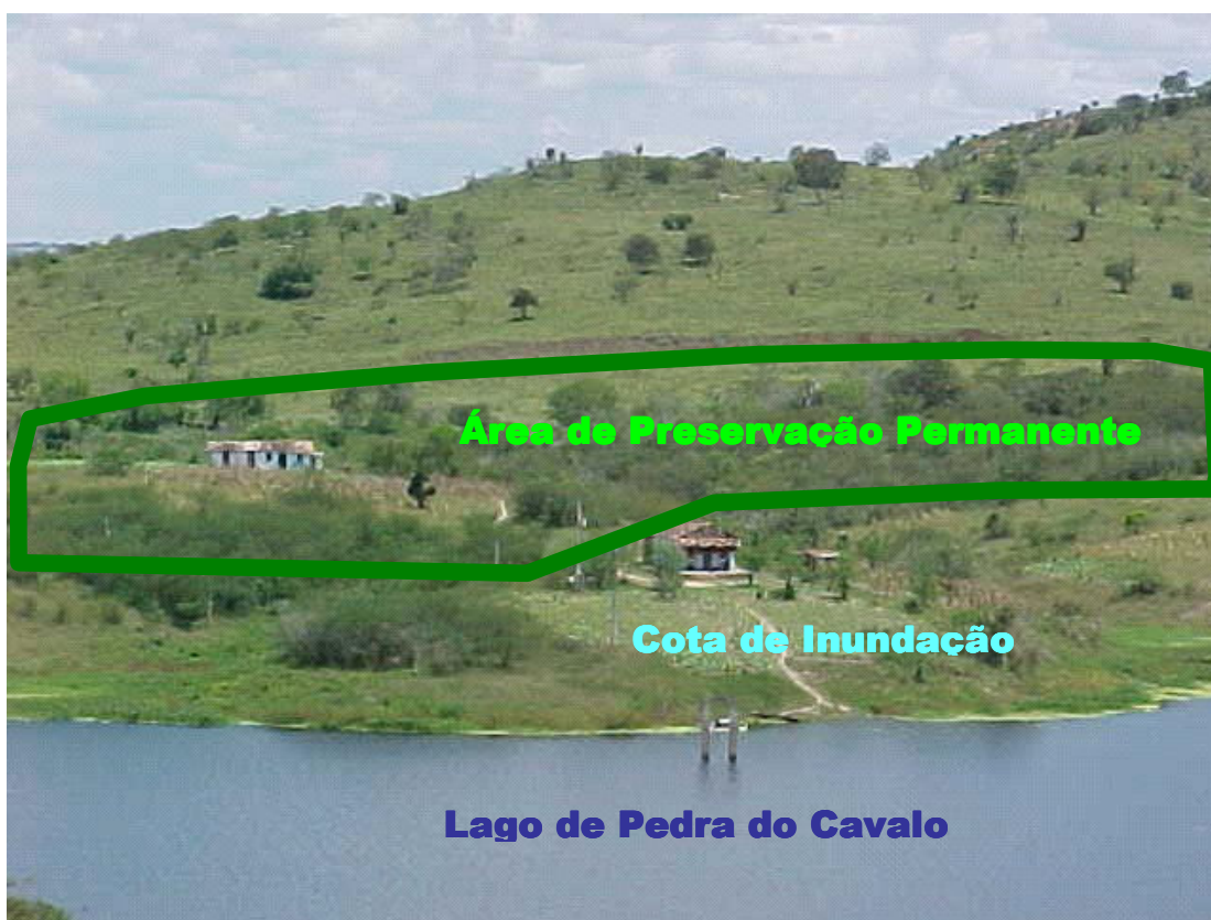
Foto 37 – Lote na cota de inundação e APP – Fz. Mocambo – Lago de Pedra do Cavallo -2006. Elaboração PALMA, E.G.A. (2007).
