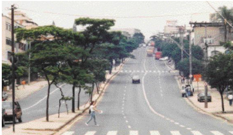
Faixa exclusiva de ônibus junto ao meio-fio em Belo Horizonte, com pista dupla nos aclives para privilegiar o transporte coletivo
