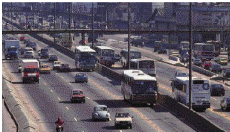
Faixas exclusivas para ônibus junto ao canteiro central – Av. Brasil, Rio de Janeiro
