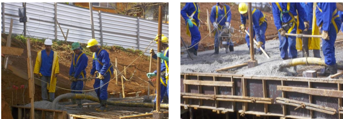
Figura 52: Concretagem do 2º teto torre Sul em 18/07/2014.
