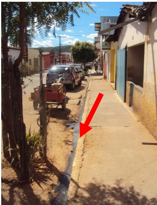
Figura 26 - Esgoto doméstico correndo a céu aberto nas ruas do município de São Desidério-BA
