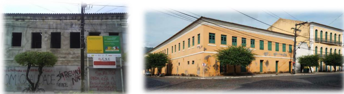
Figura 27: Instalações da UFRB durante (2008) e após a reforma do Quarteirão Leite e Alves
