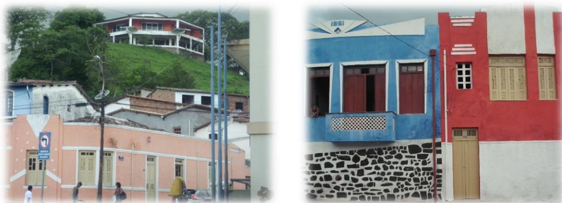
Figura 43: Descumprimento das normativas na área residencial de Cachoeira
