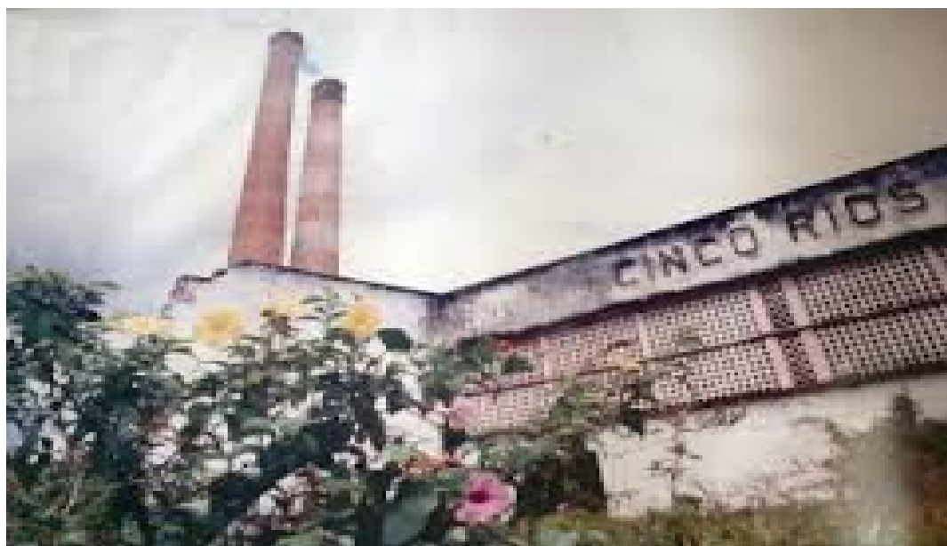
Figura 22: Usina Cinco Rios localizada em Maracangalha, São Sebastião do Passé - Ba
