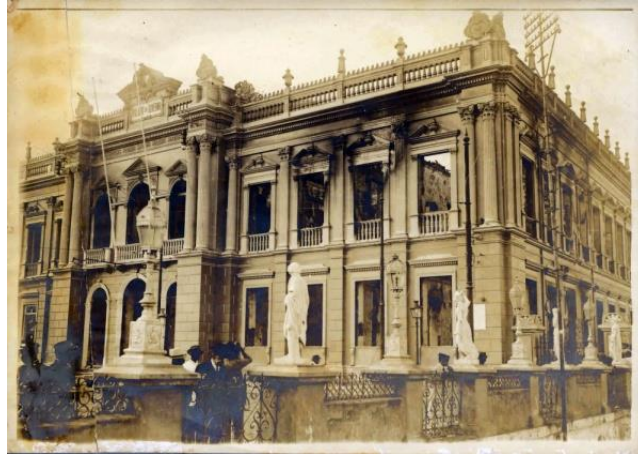
Figura 9 – Palácio do governo da Bahia. Curiosos contemplam o edifício semidestruído pelo bombardeio e intervenção federal no estado. Salvador, 1912. Fonte: sítio do Arquivo Público Mineiro (APM).
