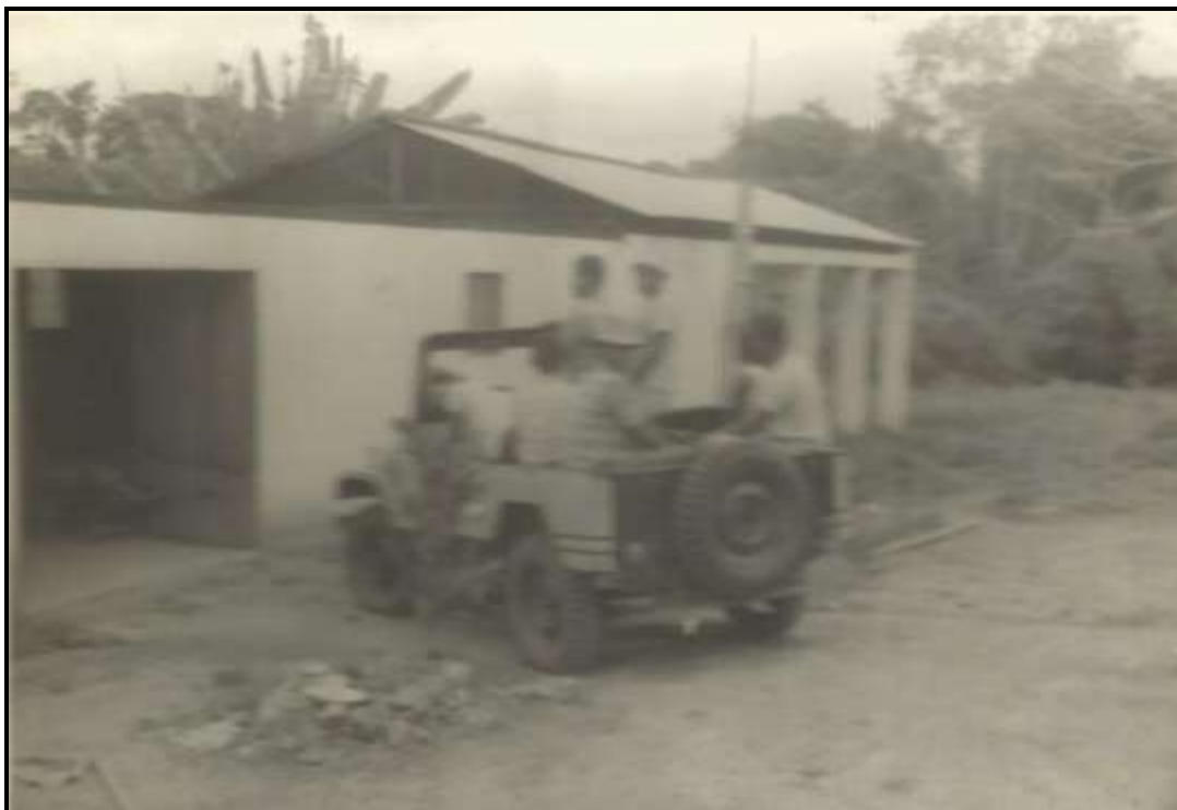
Figura 44: Trabalhadores retornando da lavoura na roça da família Kuratani. s/d. (Fotografia gentilmente cedida por Yoshimassa Kuratani)
