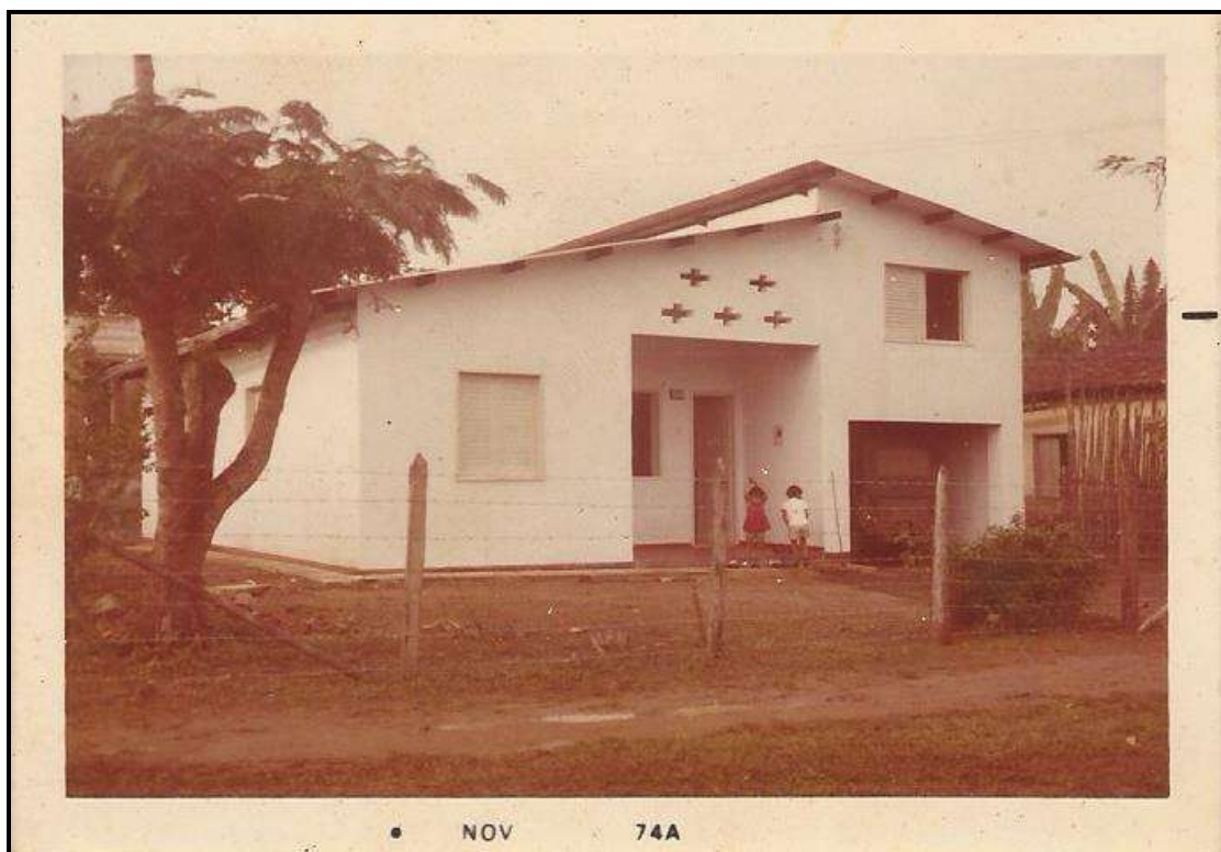
Figura 27: Casa da família Kuratani, já reformada. 1974. (Fotografia gentilmente cedida por Yoshimassa Kuratani)
