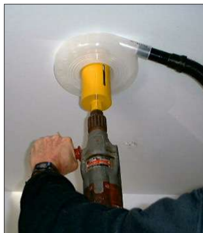
(b) Perfuratriz acoplada a sistema de coleta
