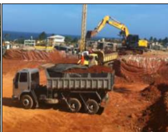
(d) Caminhão com caçamba coberta
