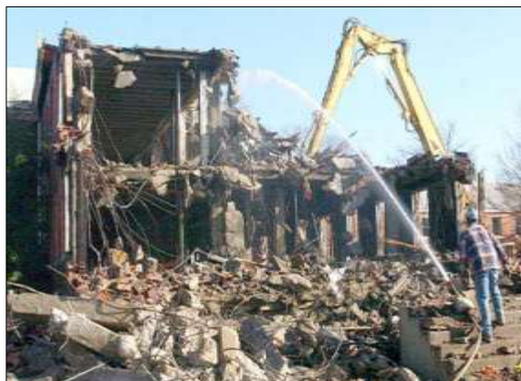
(b) Aspersão de água durante a demolição.
