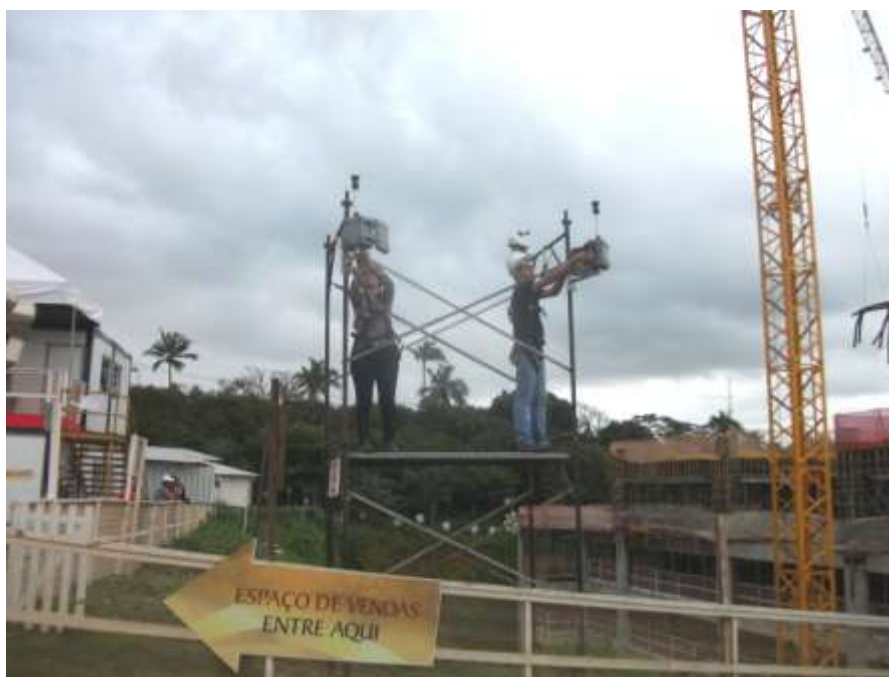
Figura 29: Retirada dos filtros
