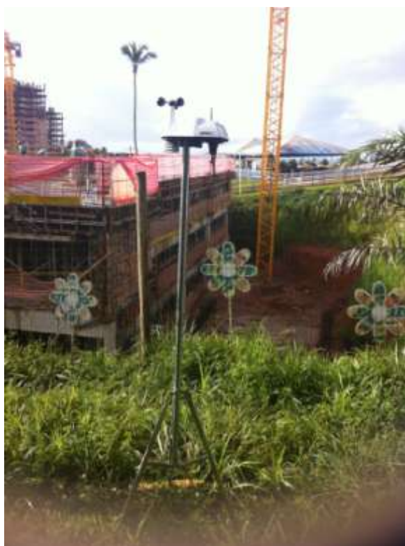
Figura 26: Detalhe da estação meteorológica
