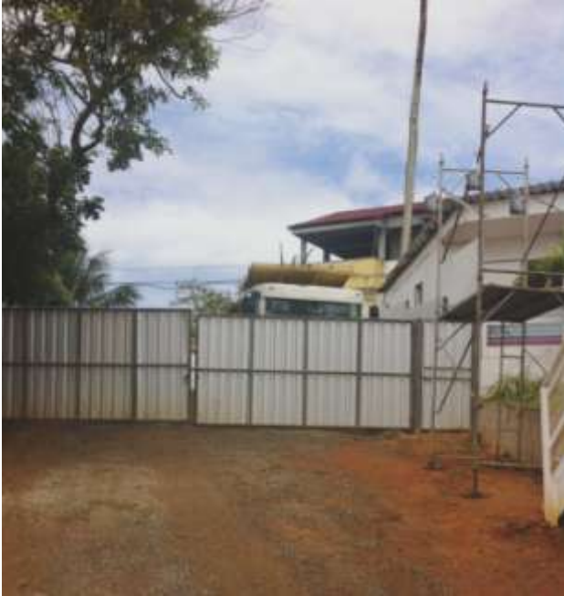
(a) Equipamento instalado a montante
