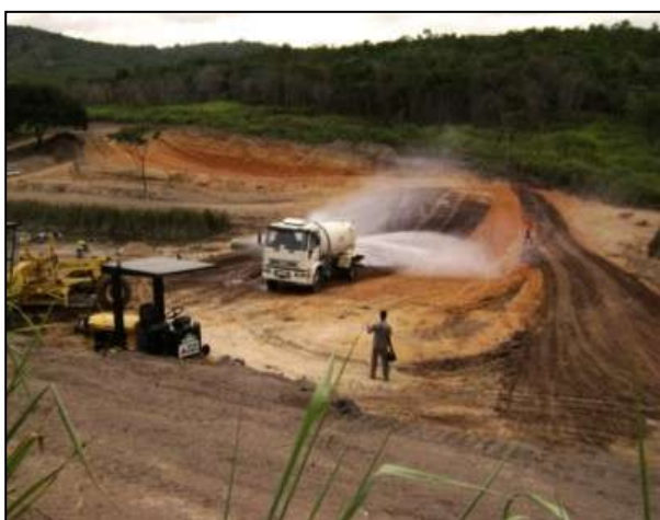
(a) molhação na terraplanagem
