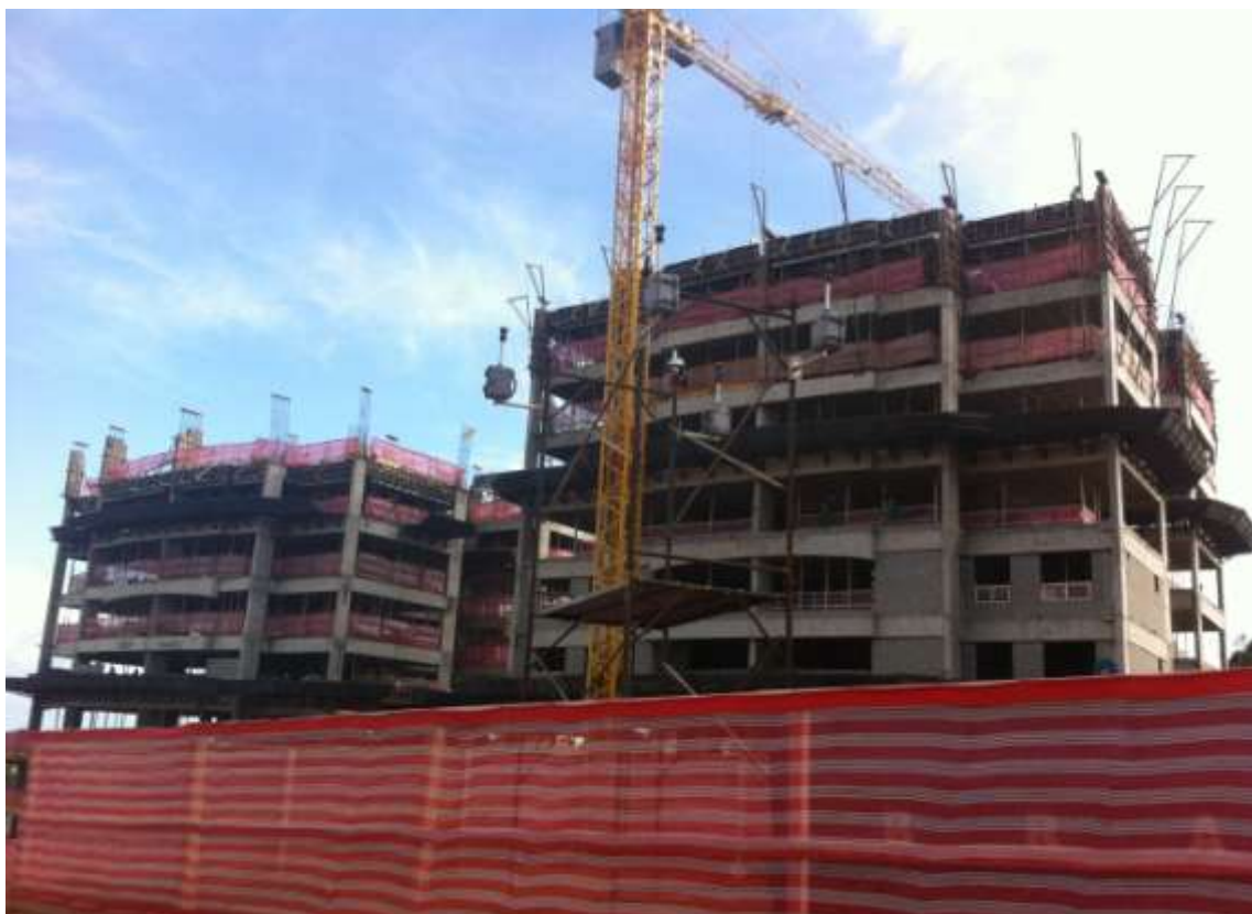
Figura 12: Andaime e equipamentos instalados no canteiro
