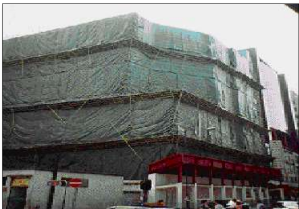
(a) Obra protegida com tela e andaimes fachadeiros.
