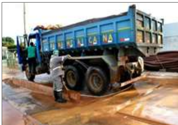
(a) Lavagem dos pneus de caminhões
