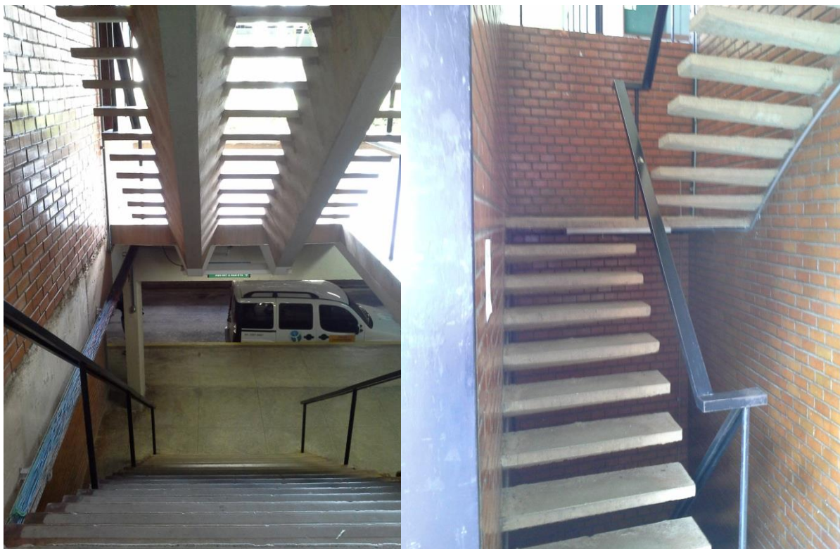
Figura 05 – Uma de duas escadas de acesso ao subsolo do ICC.
