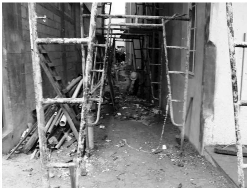
FIGURA 17: Operário fazendo triagem de resíduos em canteiro de obras nos Estados Unidos (agosto de 2008)
