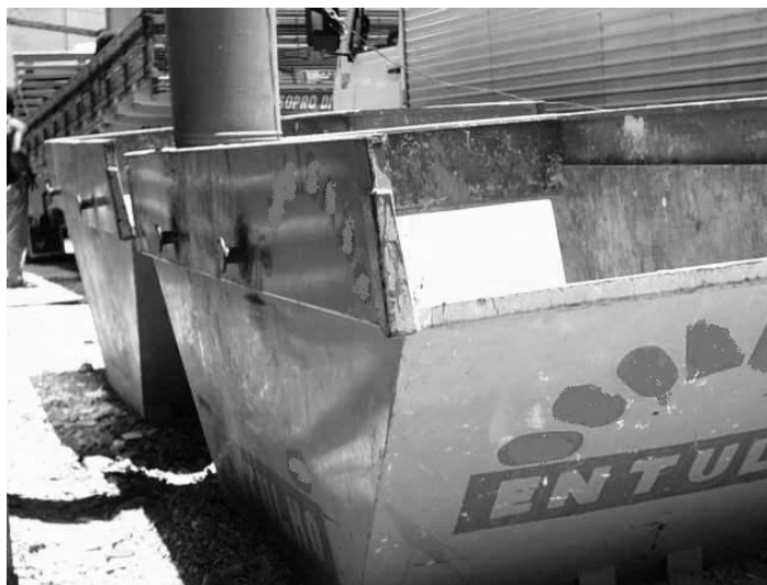
FIGURA 24: Container de empresa coletora de resíduos de construções, em canteiro de obra com implementação de gestão de resíduos em Salvador
