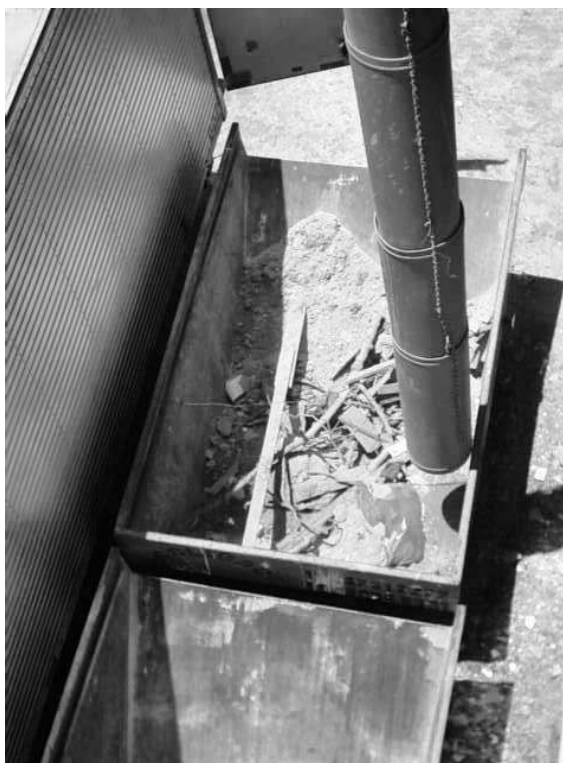
FIGURA 23: Acondicionamento de resíduos de materiais de construção, em container de empresa coletora, em canteiro de obra com implementação de gestão de resíduos em Salvador.
