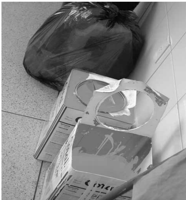
FIGURA 10: Destinação inadequada de embalagem de tinta com resíduos em reforma de uma Faculdade particular de Salvador - BA (janeiro de 2006). Fonte: fotografado por Valnêr Guimarães Junior.
