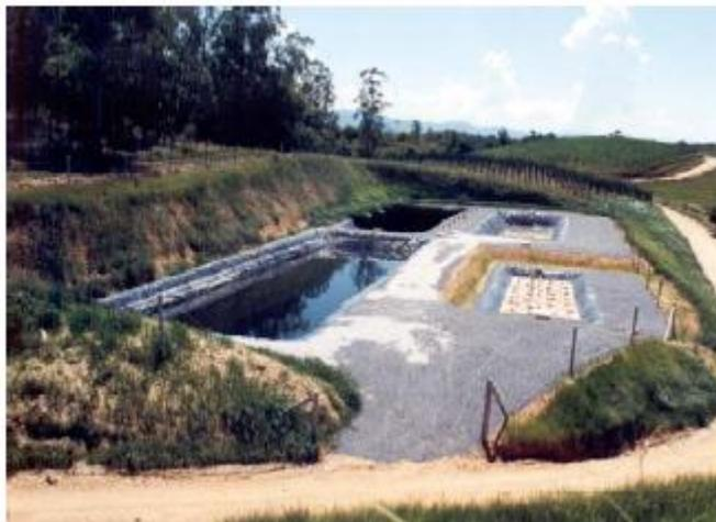
Figura 6 - Tratamento de lixiviado de um aterro sanitário com uso de lagoas de estabilização.
