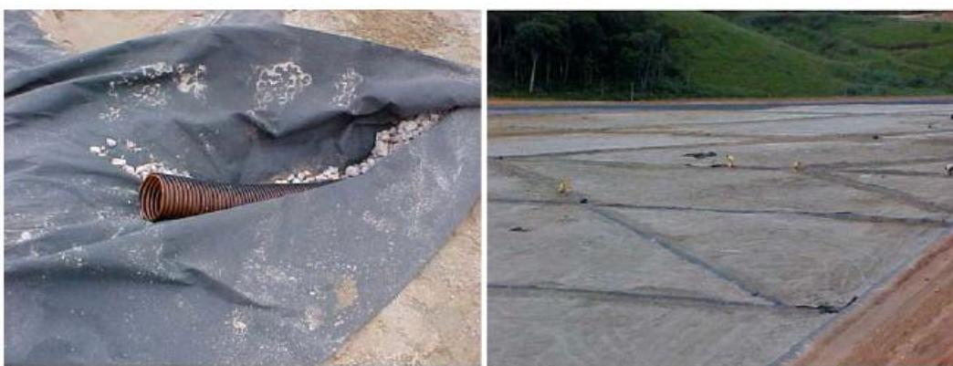
Figura 5 – Drenagem de lixiviado de um aterro sanitário
