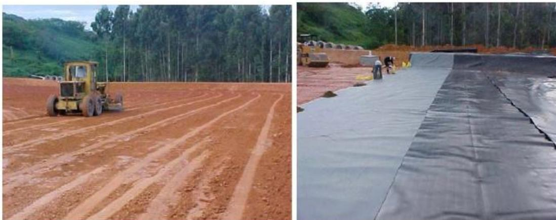
Figura 1 - Sistema de impermeabilização de base sendo executado em um aterro sanitário
