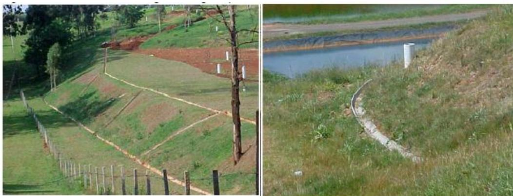
Figura 3 - Sistema de drenagem de águas pluviais de um aterro sanitário
