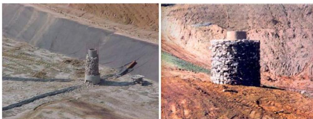
Figura 4 - Drenos de biogás do aterro sanitário
