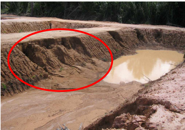
Figura 3: Ruptura na Vala do AS de Baixio Palame.
