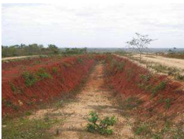
Figura 33: AS Aporá: Vala ainda sem operação. Fonte: GRSU / UFBA
