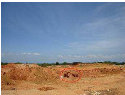
Figura 20: AS de Saubara: Sinais de erosão do solo. Fonte: CAMPOS, L., 2007.
