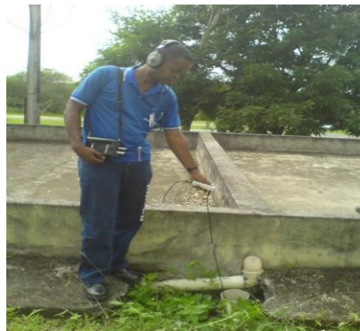
28- Procedimento de pesquisa de vazamento com geofone eletrônico
