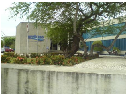
1 - Fachada principal da edificação
