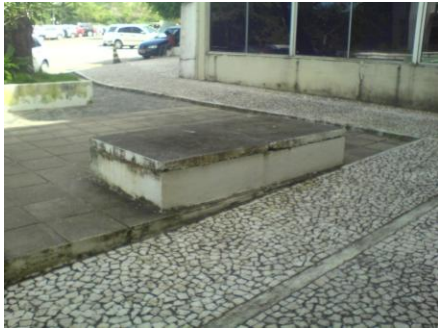
7 - Reservatório enterrado RE1
