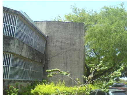
10 - Reservatório elevado REL 2
