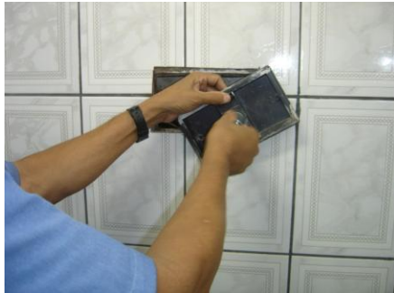
24 - Serviços de manutenção hidráulica
