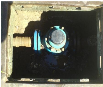
23 - Hidrômetro da Embasa depois da manutenção
