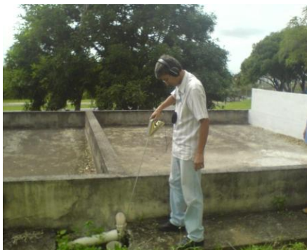
27 - Procedimento de pesquisa de vazamento com haste de escuta
