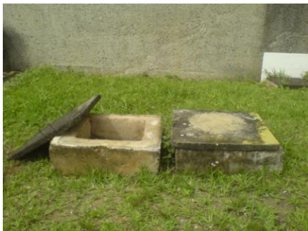
11- Reservatório enterrado RE3
