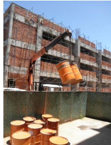
Figura 20. Içamento de Tambores Fonte: Arquivo Pessoal
