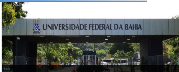
Figura 6. Portaria Principal da UFBA Fonte: Site Institucional UFBA
