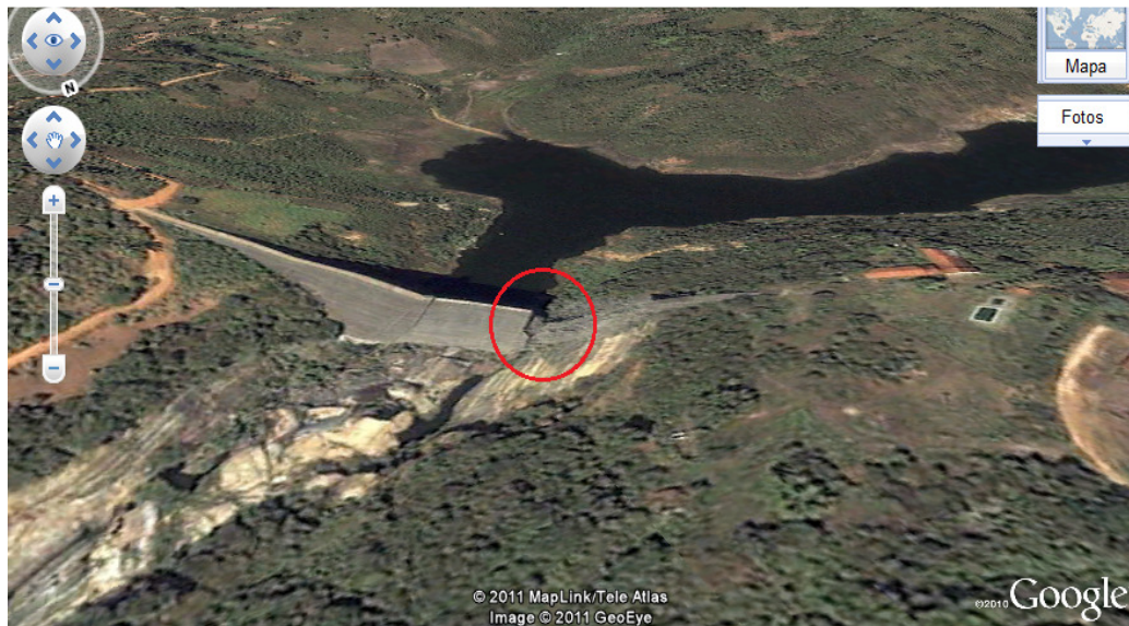
Figura 8 – Rompimento da Barragem de Camará na Ombreira Esquerda. Fonte: Google Earth, 2011.
