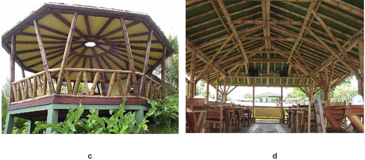
Figura 15 – Coberturas: coretos e galpões.
