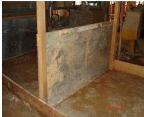
Figura 22 Baías para segregação dos agregados - Estudo de Caso 1
