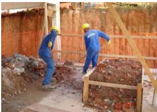
Figura 27 Cubagem para britagem piloto – Estudo de Caso 1
