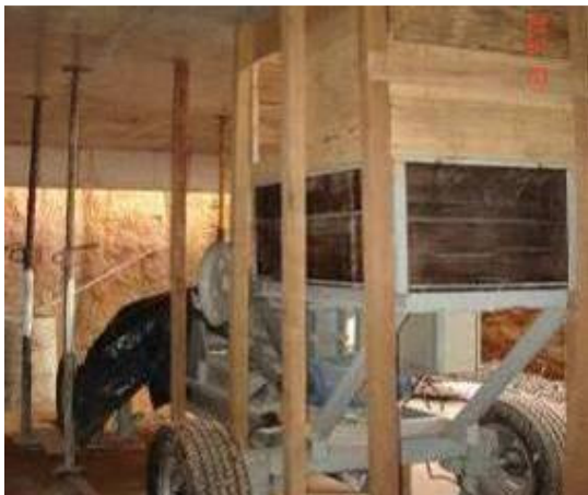
Figura 21 Instalação da recicladora móvel – Estudo de Caso 1
