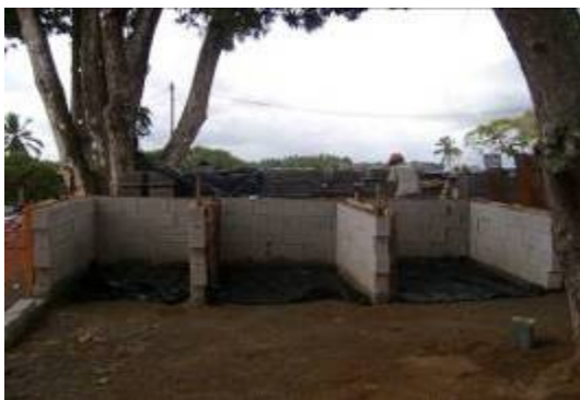
Figura 32 Baías para armazenamento dos agregados – Estudo de Caso 2
