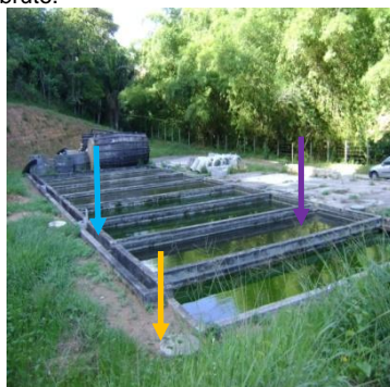
Figura 9(c) – Leitos de secagem e calha transportadora do efluente da segunda lagoa para os leitos de secagem.
