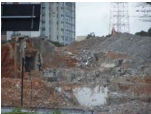
Figura101. Canteiro da Arena Fonte Nova em 15/09 às 15h e 27min.
