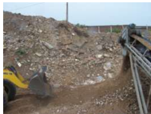
Figura 50. Espalhamento da pilhas de agregado reciclado - Usina “C”.
