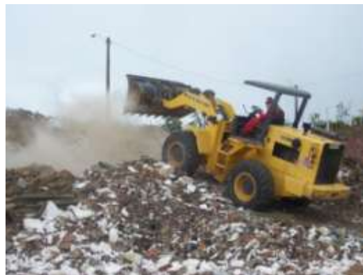
Figura 48. Nivelamento da pilha de RCC em área de armazenagem. Usina “C”.
