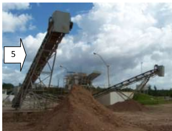
Figura 43. Transportador de Correia Móvel – TCM (5). Usina “B”
