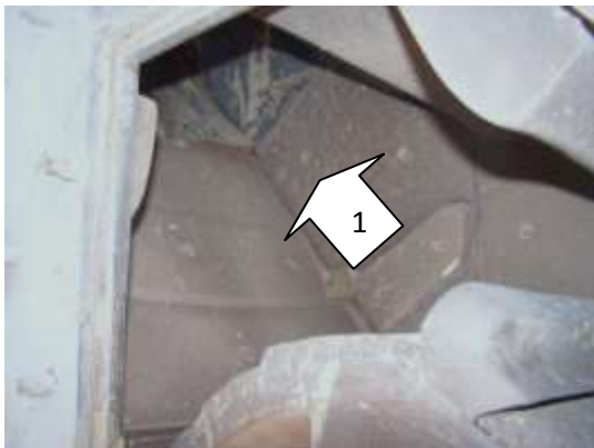
Figura 40. Acesso do RCC a britar (1).
