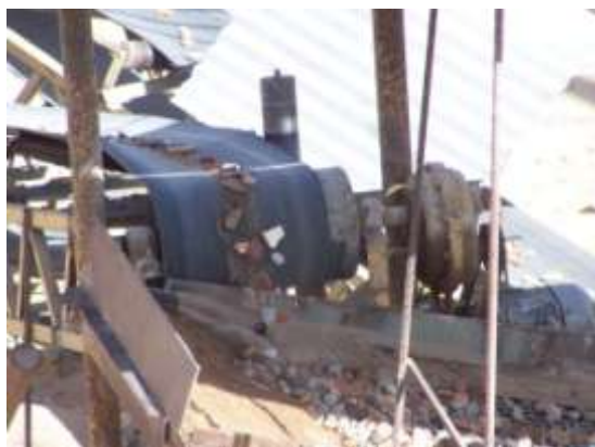
Figura 36. Descontinuidade na alimentação da bandeja de vibração do britador.
