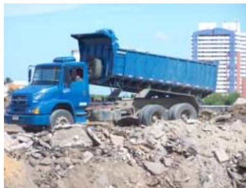
Figura (j). Caminhão truck dispendo RCC (2010).
