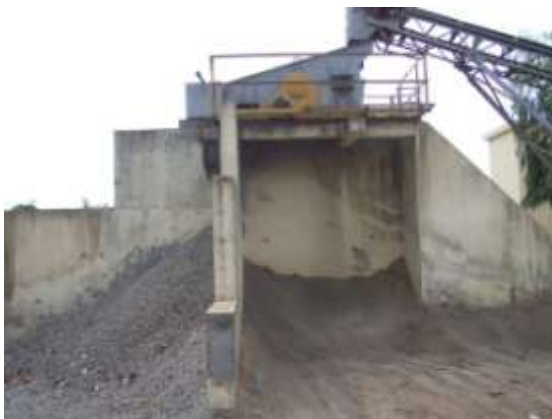
Figura 69. Armazenagem em baias - Usina "C".
