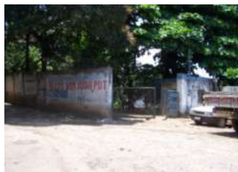
Figura 96. PDE (NL 04) Av. San Martin (acesso pela Rua do Forno. Out. 2010).
