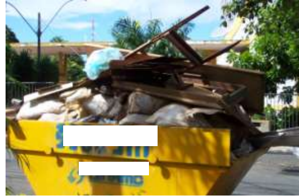
Figuras 04. Armazenagem de RCC em Caçambas
