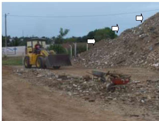
Figura 27. Armazenagem de RCC – Usina “C”.
