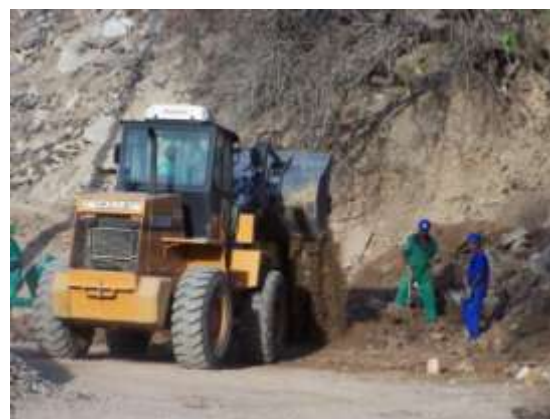
Figura 35. Coleta, espalhamento de RCC e triagem manual de resíduos – Usina “D”.
