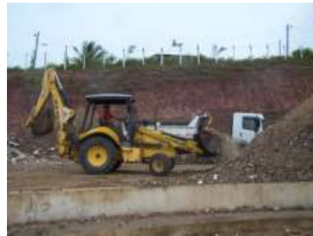
Carregamento de veículo de transporte com retro-escavadeira.
