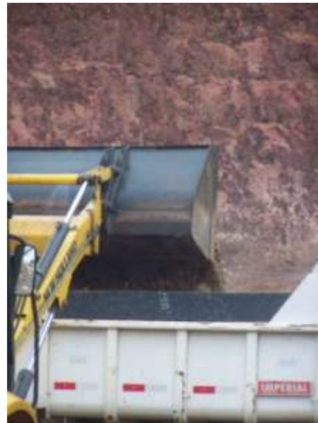
Disposição de agregado reciclado na caçamba do veículo.
