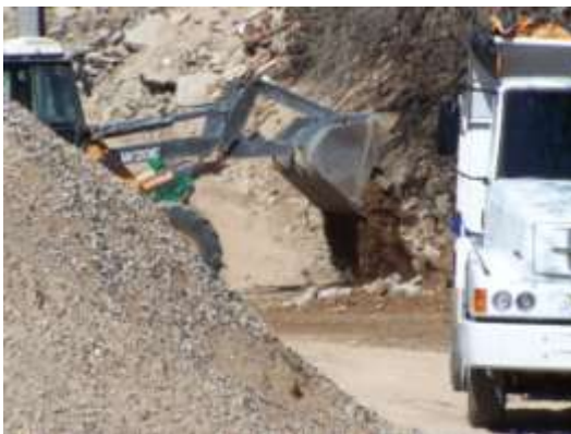
Figura 47. Espalhamento de RCC para triagem. Usina “D”.
