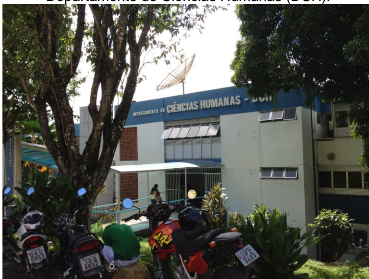
Fotografia 9 – Prédio de aulas dos acadêmicos do curso de direito da UNEB - Campus I, Departamento de Ciências Humanas (DCH).
