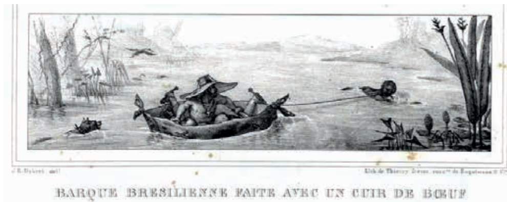
Figura 1: Pintura retratando a travessia de um rio através da pelota. (DEBRET, 1835, p.94)
