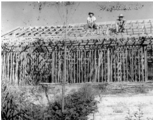
Foto 11 - Núcleo JK - Construção da residência dos Nishitani.
