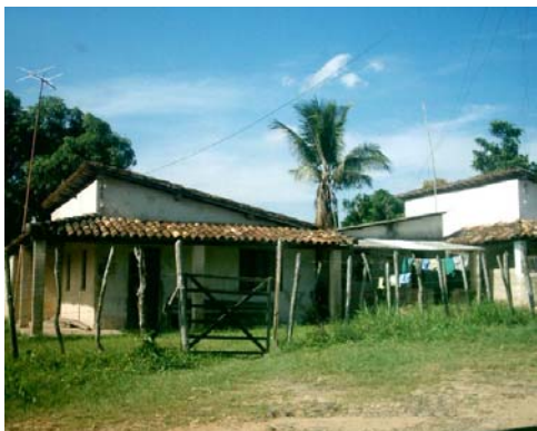
Foto 44 – NJK - Vila Camaçari: aspectos dos espaços construídos
