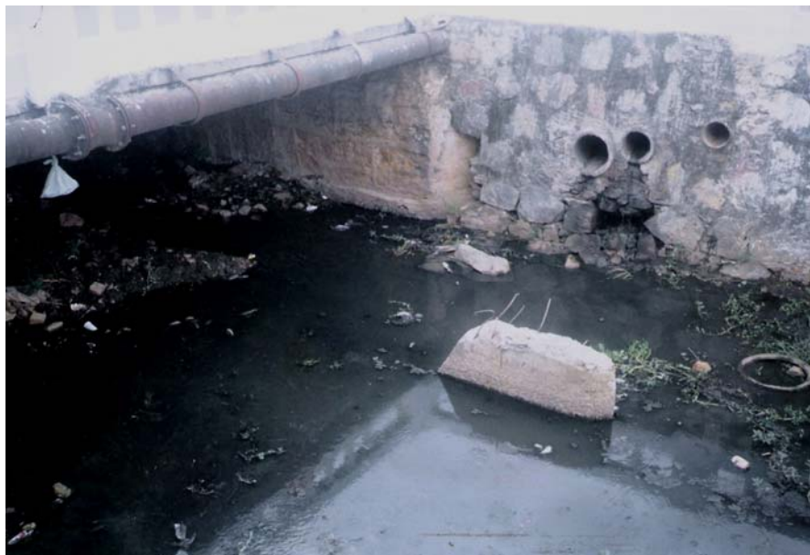
Figura 53 – Rio com baixa vazão em período de estiagem, transformado em esgoto.
