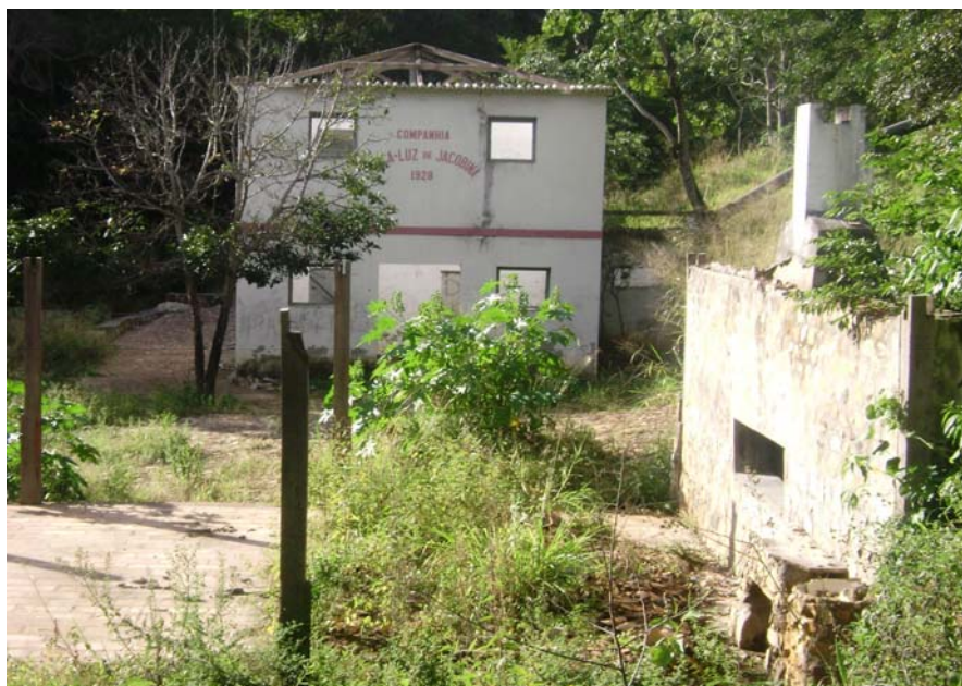
Figura 6 – Casa das máquinas da Companhia Força e Luz de Jacobina, restaurada e depredada.
