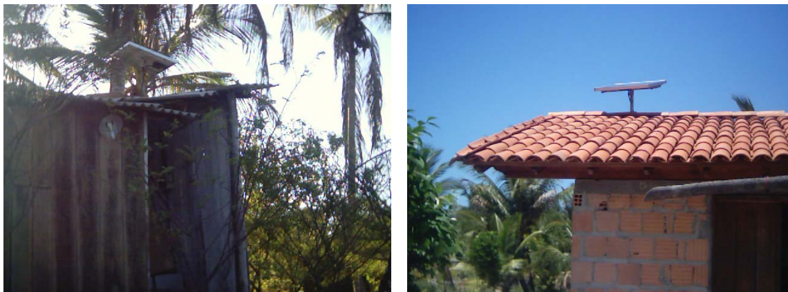
Figura 48: Casas com painéis solares
