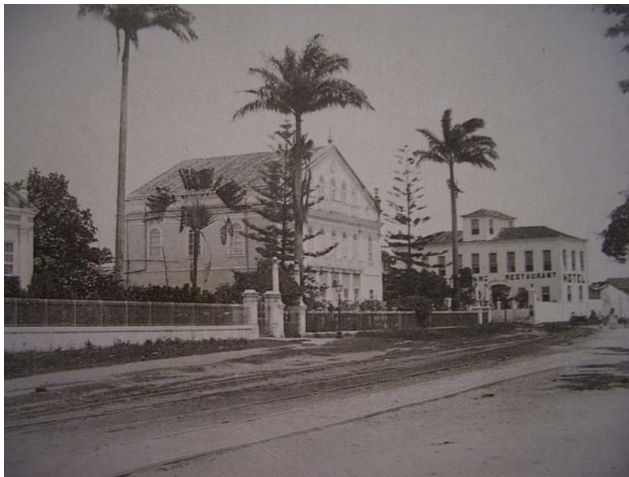
Figura12: Hotel dos Estrangeiros, 1875, atual esquina do Campo Grande com a Rua Araújo Pinho
