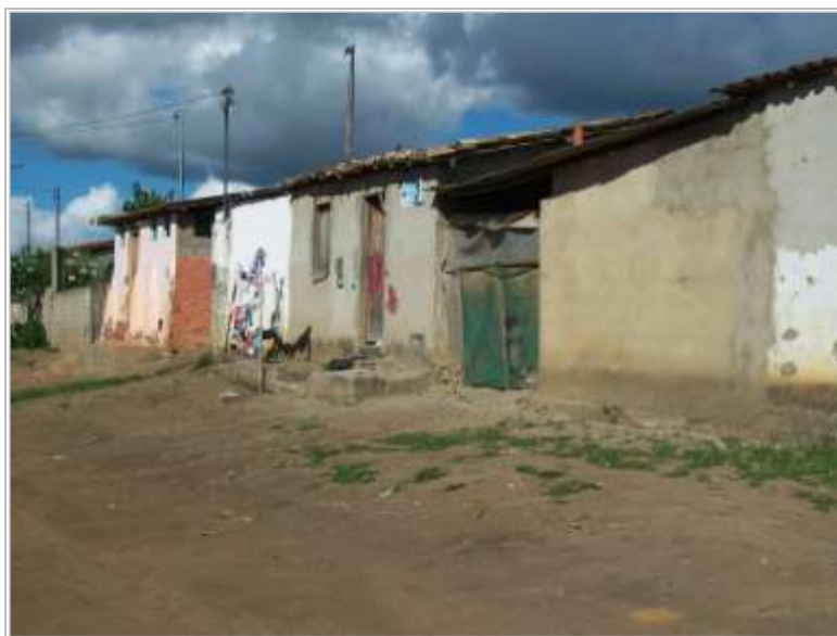
Figura 03: casa localizadas na entrada da cidade, Rua São José, Barra do Choça, 2011
