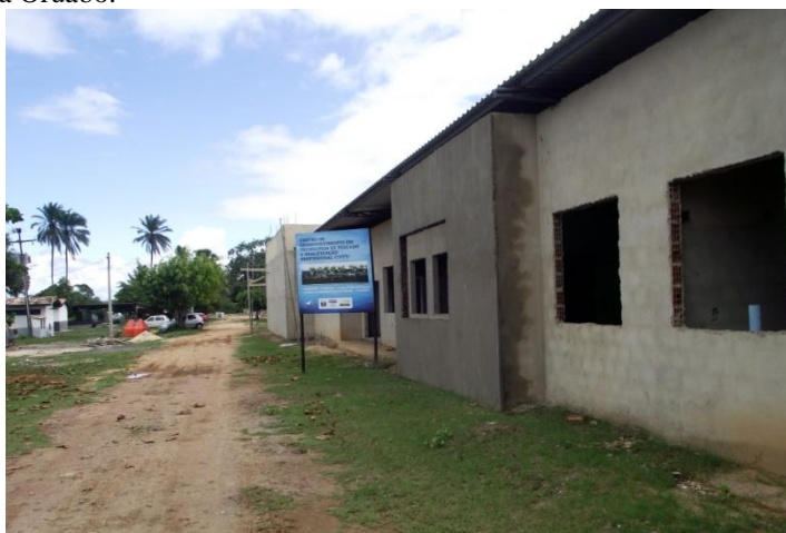
Figura 60. Obras da construção do Centro de Desenvolvimento em Tecnologia de Pescado e Qualificação Profissional na Fazenda Oruabo.
