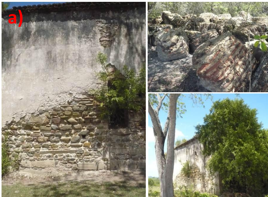
a) Estrutura das paredes feitas com a utilização de óleo de baleia. Fonte: Kássia Rios, pesquisa de campo, 2012.
