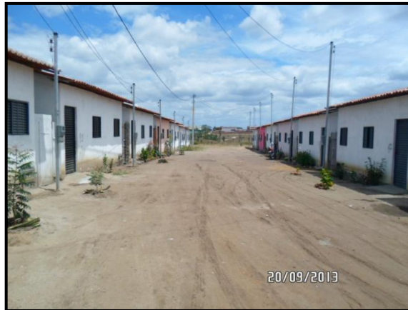
Figura 25 – Rua do CHI – B após limpeza dos moradores Fonte: Próprio autor (2013)
