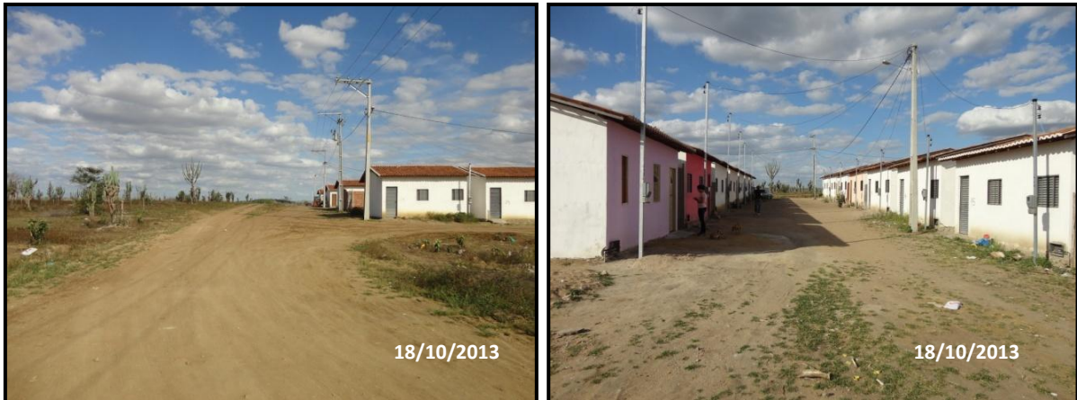
Figura 22 - CHI – B sem delimitação da área e rua sem calçamento
