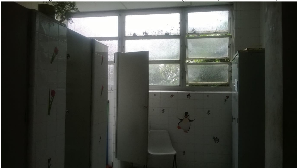
Figura 18 – Banheiro feminino do Instituto de Biologia/ 1º andar (área exterior à cabine).
