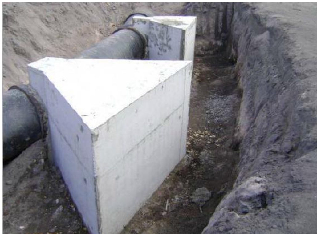
Figura 2.9 – Bloco de ancoragem em uma adutora de diâmetro interno 900 mm (DI 900). Fonte: Embasa (2010)
