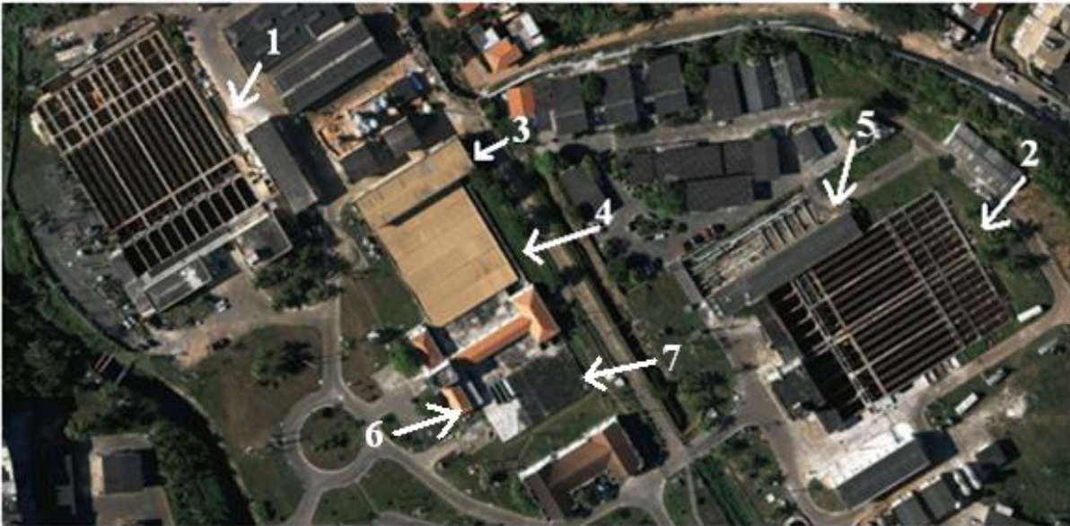
Figura 2.1 – Vista aérea do complexo do sistema de abastecimento de água - complexo da Bolandeira, Salvador-BA, 2010
