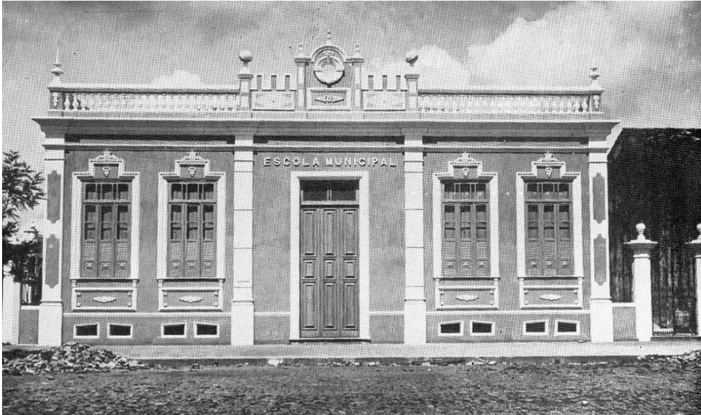
Figura 6-Prédio da Escola Municipal João Florêncio
