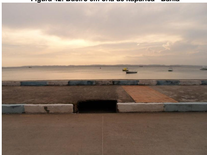
Figura 42: Bueiro em orla de Itaparica - Bahia
