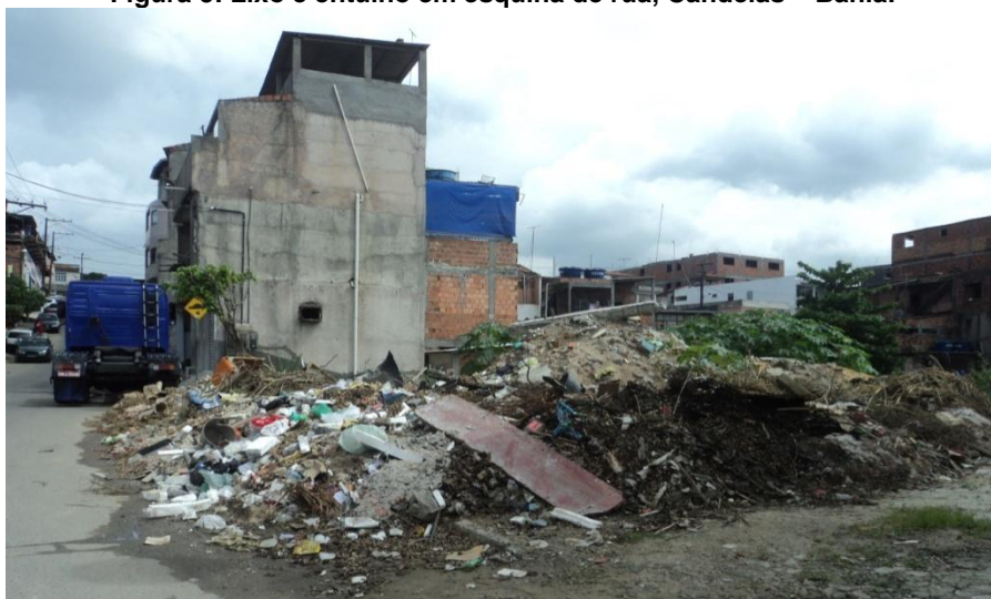
Figura 5: Lixo e entulho em esquina de rua, Candeias – Bahia.
