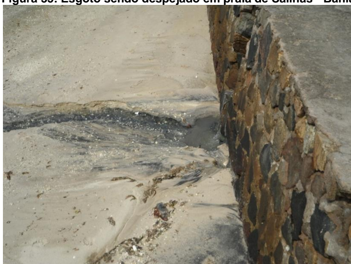
Figura 35: Esgoto sendo despejado em praia de Salinas - Bahia
