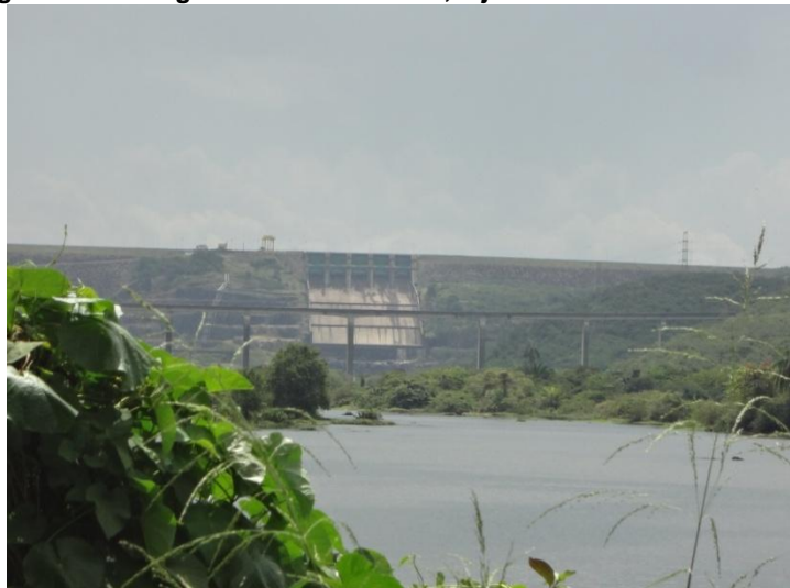
Figura 25: Barragem Pedra do Cavalo, à jusante de São Félix - Bahia
