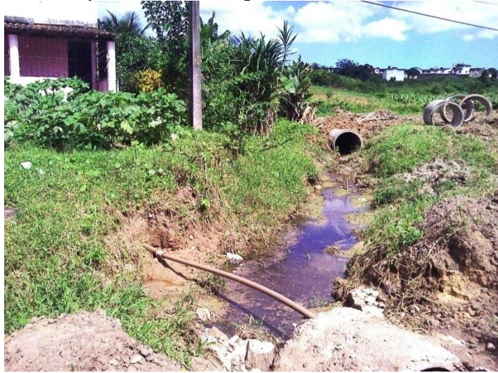
Figura 14: Casa próxima a um córrego a céu aberto, Santo Amaro – Bahia.
