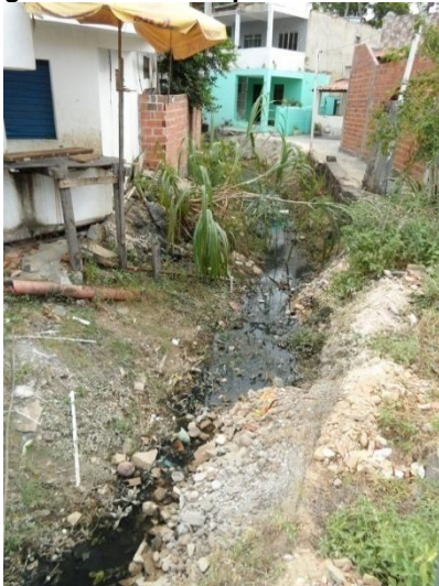
Figura 40: Córrego de esgoto a céu aberto próximo de moradias, Mar Grande - Bahia
