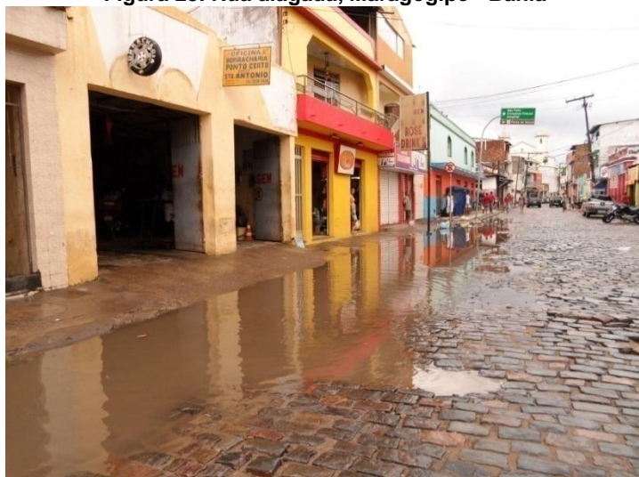
Figura 28: Rua alagada, Maragogipe - Bahia
