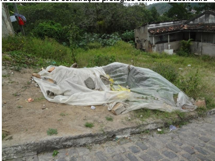
Figura 20: Material de construção protegido com lona, Cachoeira - Bahia
