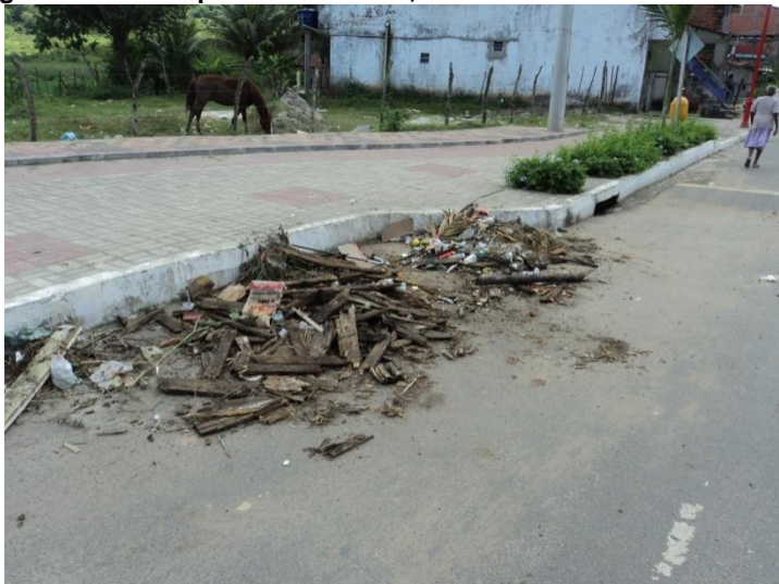
Figura 8: Entulho próximo a bueiro, S. Francisco do Conde – Bahia.
