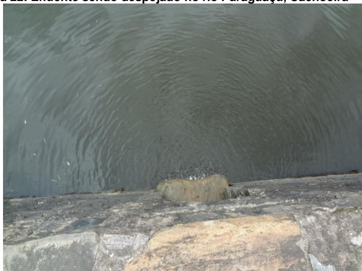
Figura 22: Efluente sendo despejado no rio Paraguaçu, Cachoeira – Bahia.
