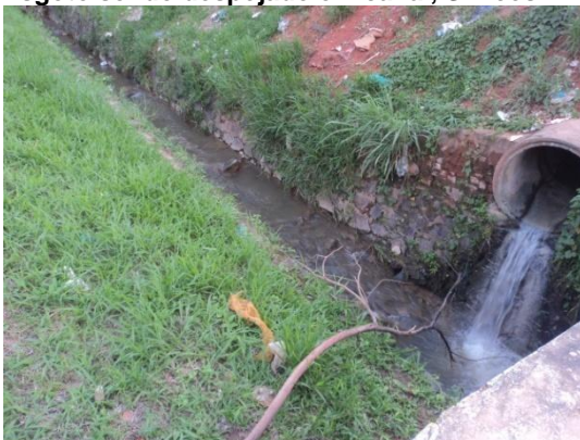
Figura 3: Esgoto sendo despejado em canal, Simões Filho – Bahia.
