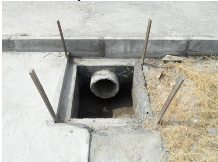
Figura 36: Sistema de drenagem sendo instalado em orla de Salinas - Bahia
