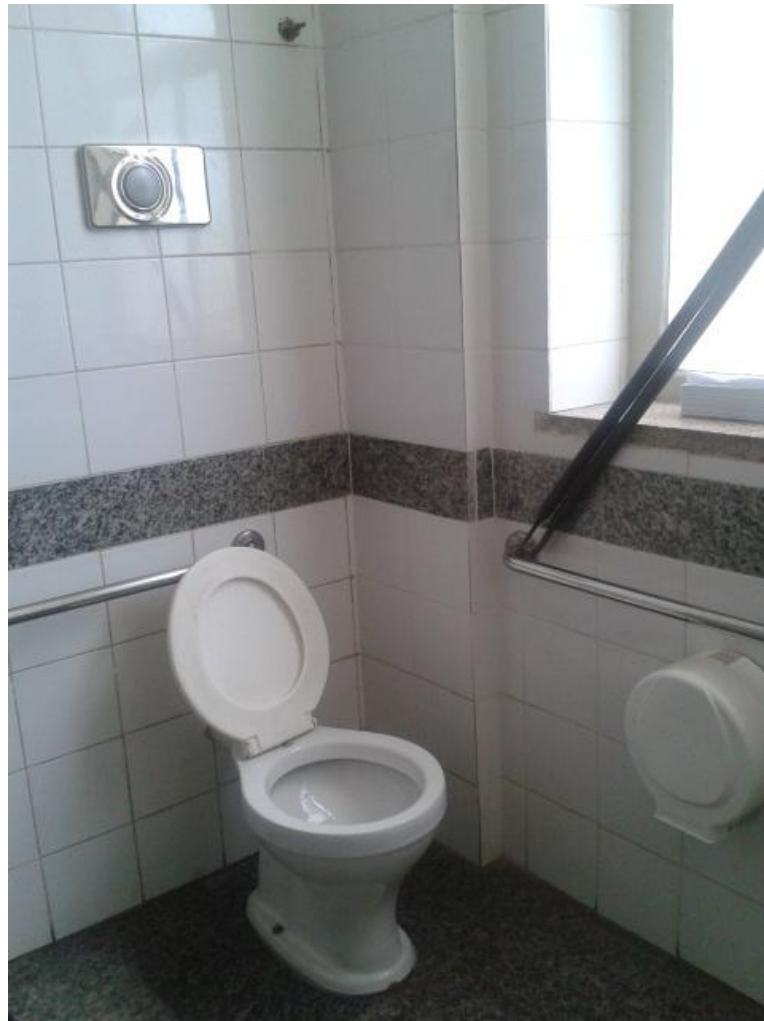
Fig. 05 Barras de segurança presentes em sanitários adaptados. O comando da descarga encontra-se localizado acima da altura acessível ao cadeirante.
