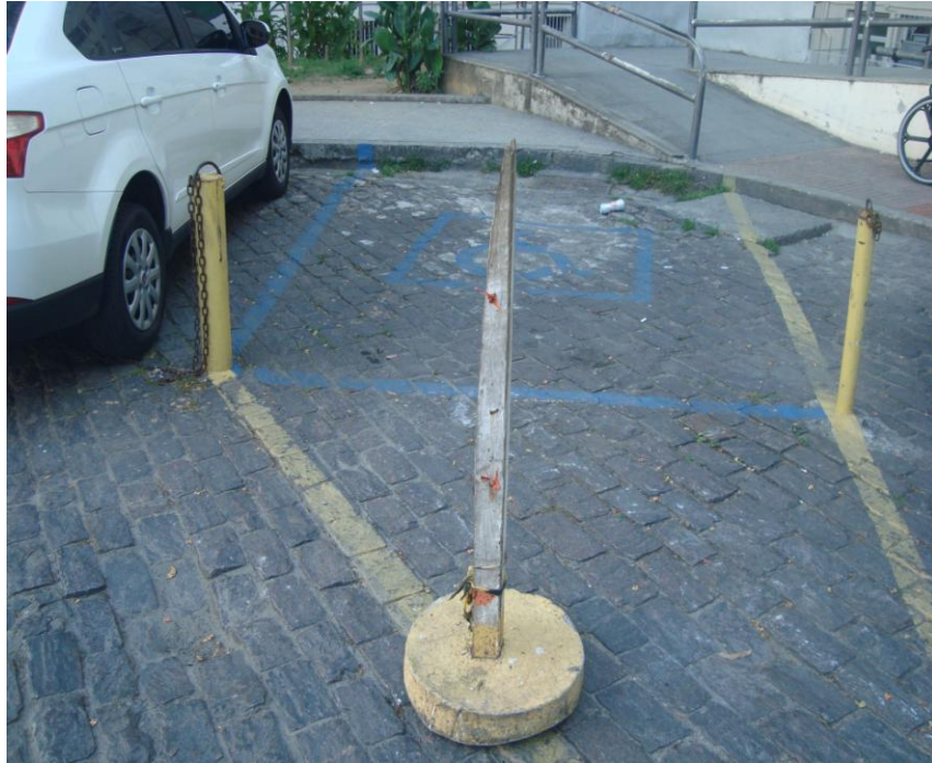
Fig. 01: Vaga de estacionamento preferencial com símbolo internacional de acesso fora das especificações gráficas; ausência de sinalização vertical. Não se encontra demarcado o espaço adicional de circulação (mínimo de 1,20m) para manobras da cadeira de roda. Presença de anteparo e barras de ferro com correntes colocadas para impedir o estacionamento de veículos utilizados por pessoas que não possuem deficiência ou restrição de mobilidade.
