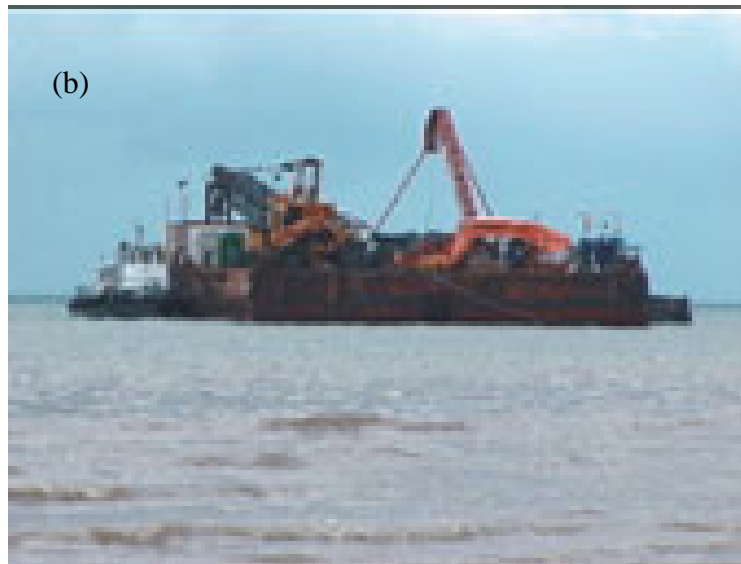
Figura 20: (a) Momento do desenrolamento do cabo para o lançamento no mar; (b) Embarcações utilizadas para a instalação do cabo: balsa, rebocadores, guindaste e guincho ( http://www.prysmianclub.com.br/revista/PClub_15/telecom.html , acessado em 20/04/2008).
