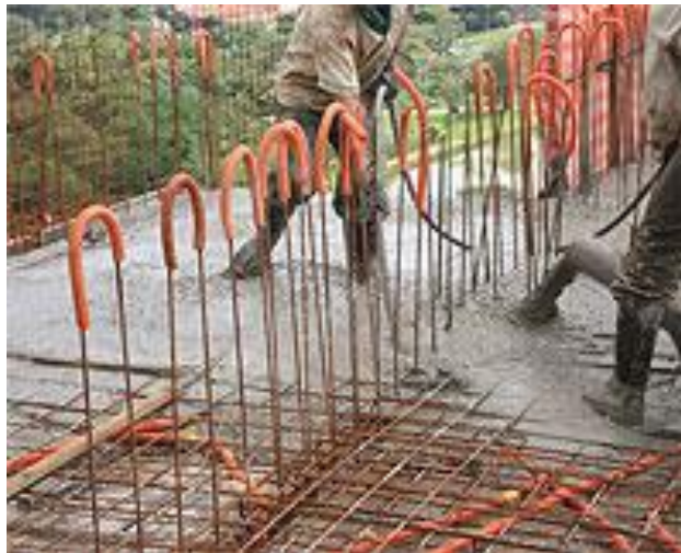
Figura 3.4. Concretagem de paredes de concreto e lajes
