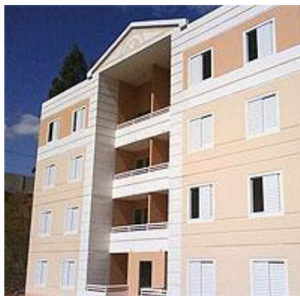
Figura 3.6. Edifício feito com paredes de concreto
