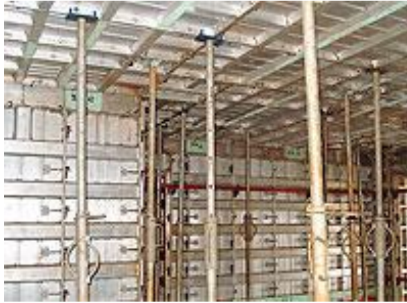
Figura 3.3. Escoramento dos painéis de laje
