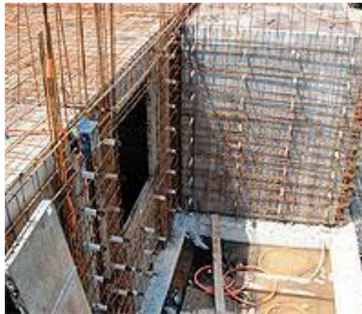
Figura 3.2. Montagem dos painéis internos
