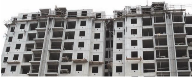
Figura 3.5. Edifício desformado
