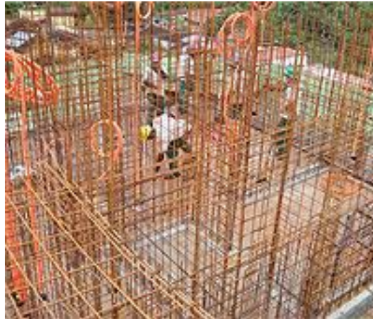
Figura 3.1. Montagem das armaduras da parede de concreto e os eletrodutos
