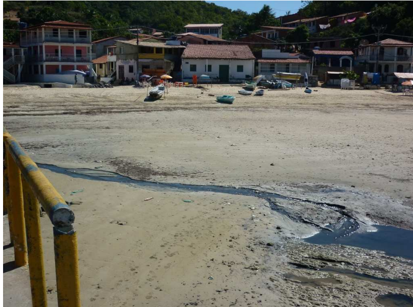
Figura 13: Falta de canalização de esgoto (Foto: Lívia Gonçalves, 2013).
