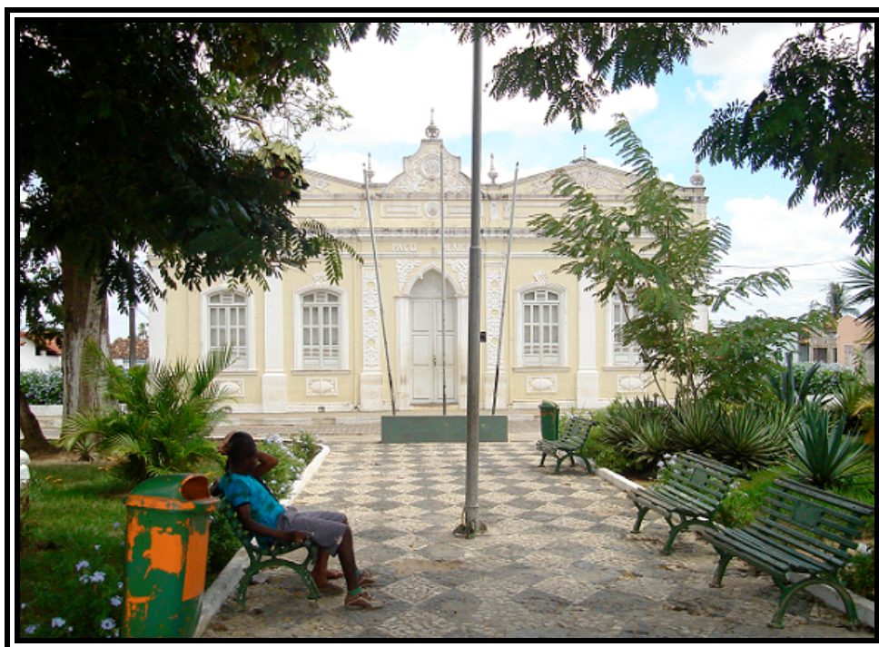
Figura 3. Vista parcial da Prefeitura de Coração de Maria (Sede). Foto realizada pela autora (2005).
