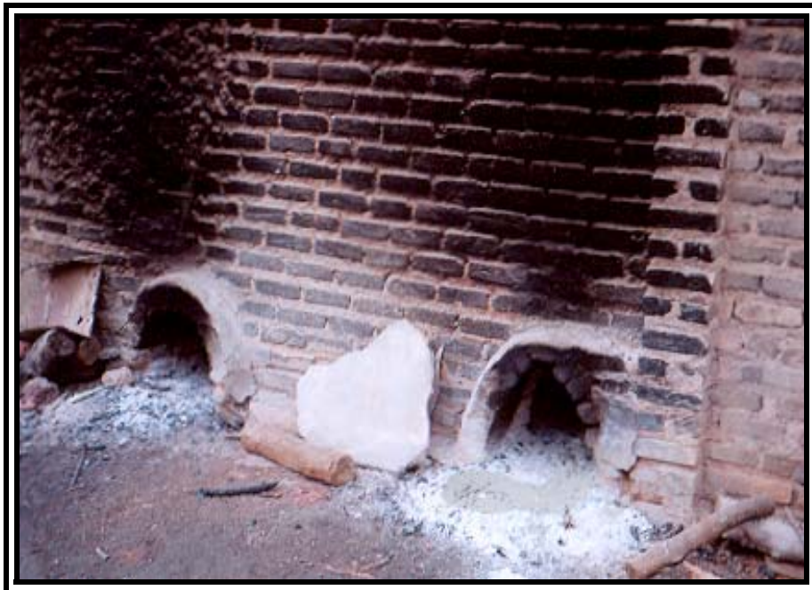
Foto 20. Abertura por onde é colocada a lenha para o aquecimento do forno da casa de farinha. Foto realizada pela autora em 2005.
