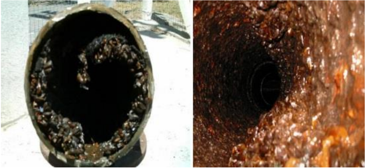
Figura 3. Tubulações de usinas hidrelétricas colonizadas por mexilhões dourados. Fonte: PHILLIPS et al., 2005.
