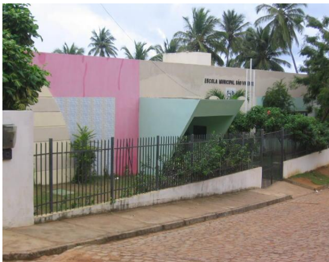
Figura 19: Vista frontal da escola Municipal
