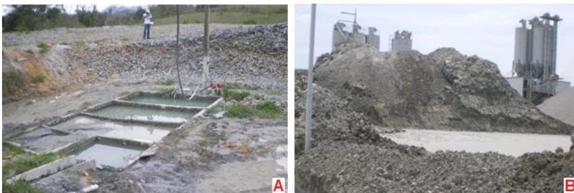
Figura 4: Etapas do tratamento de efluentes, A) Decantação dos efluentes com a separação do resíduo, B) Secagem do resíduo fino de rochas.
